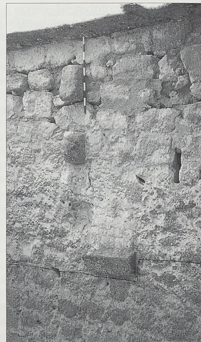
Castillo de Peñarroya. Restos de un arco que daba acceso a la liza desde la puerta exterior situada a los pies de la torre del homenaje. Ambas puertas formarían un típico acceso en codo.
