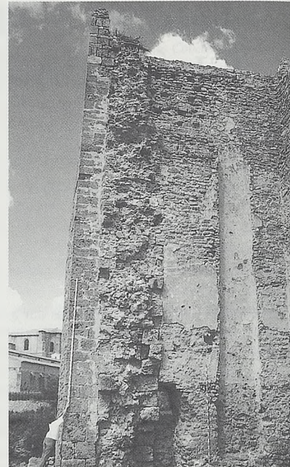
Foto 2. Torre gótica del alcázar. En la fractura se aprecia como apoya sobre el lienzo de sillares islámicos que debía tener aquí casi toda su altura original.
