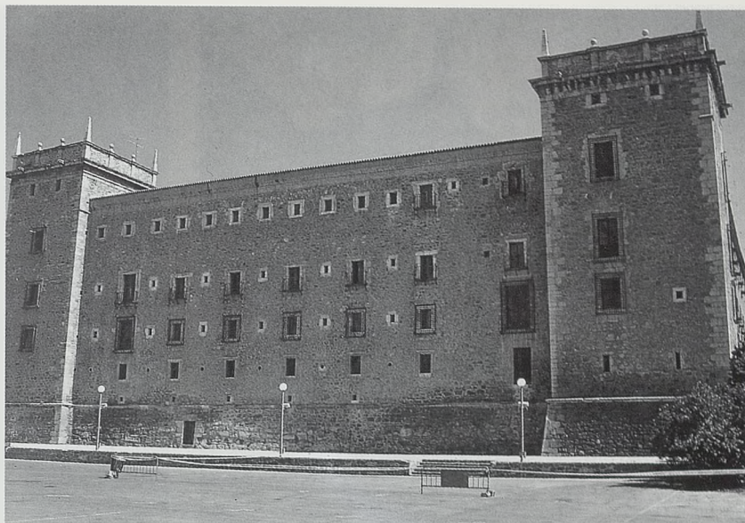
Vista actual del reprimado Real Monasterio del Puig.
