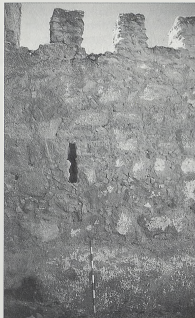
Cortina exterior del castillo de Peñarroya. Obsérvese la sólida cimentación sobre la roca madre.
