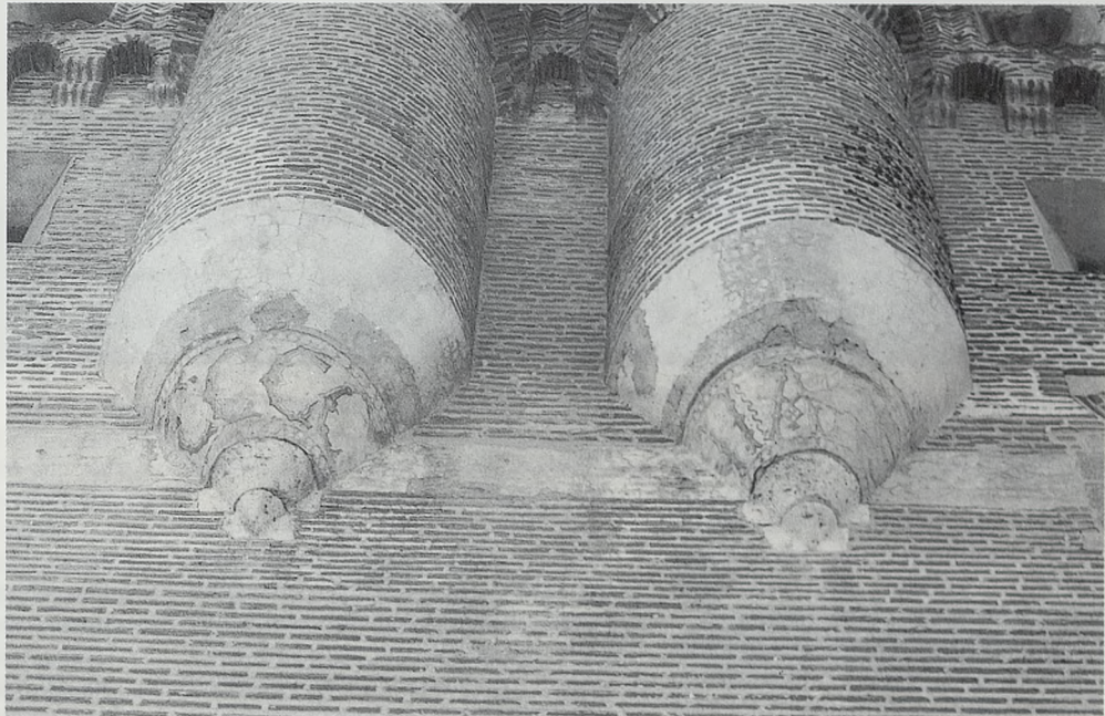
Torre del homenaje, lado norte, con el detalle de una fecha.
