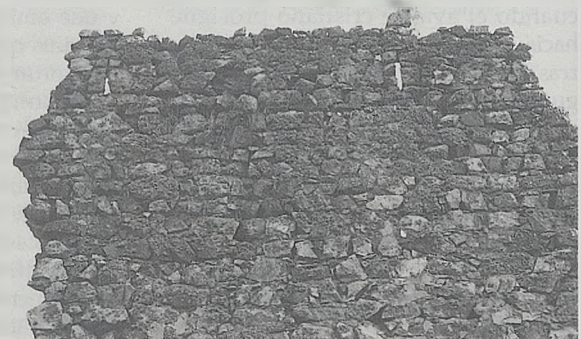
Detalle de la parte alta donde se observan las saeteras.
