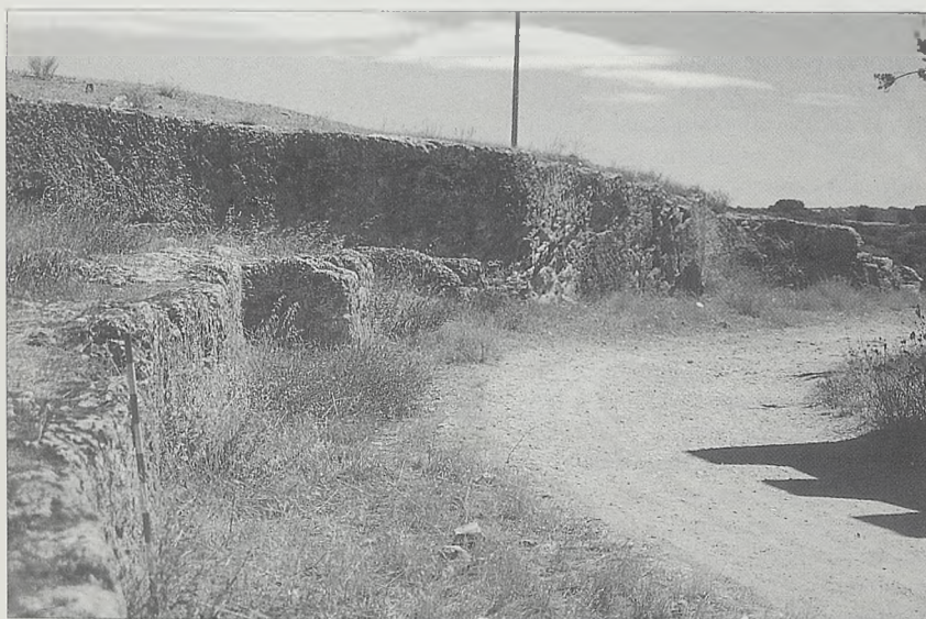
Foso excavado en roca del castillo de Peñarroya.
