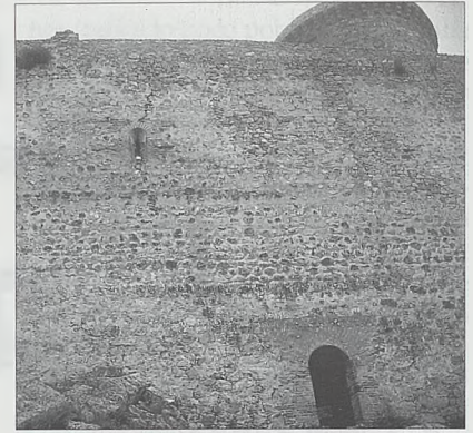
La Puebla de Alcocer. El frente este con la entrada al segundo recinto.
