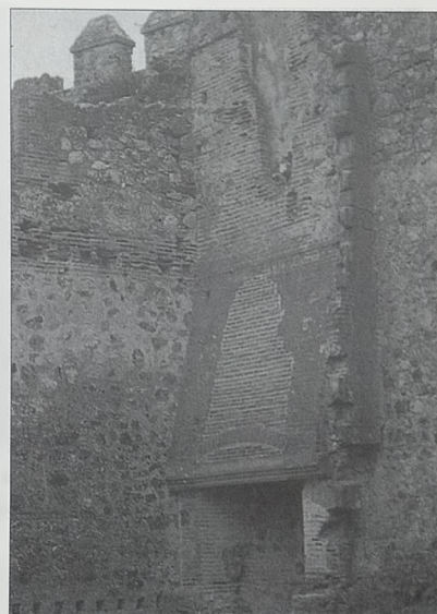
La Puebla de Alcocer. Chimenea de la sala noble del palacio.
