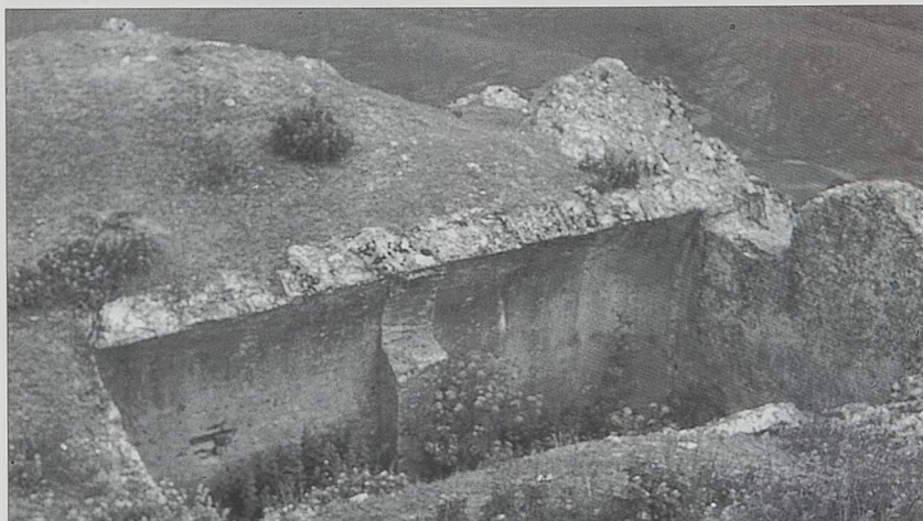
Aljibe del castillo. Se aprecia el arco fajón, el arranque de la bóveda y el revestimiento a la almagra.
