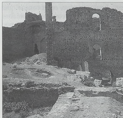
La Puebla de Alcocer. El recinto oeste desde el portillo de paso al recinto oeste.
