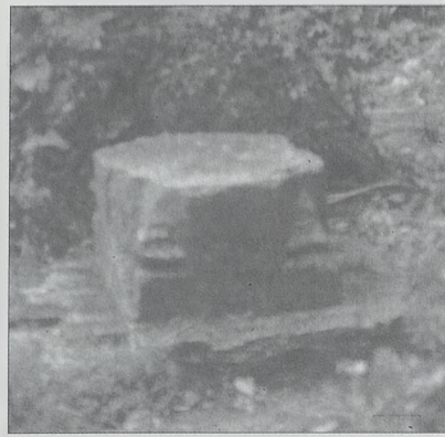
La Puebla de Alcocer. Una de las bases de los pilares del pórtico del palacio.
