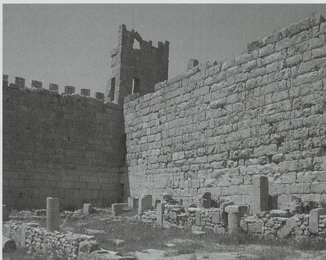
Ksar Lamsa: detalle del interior del ángulo suroeste donde se ven los tres niveles de puertas de entrada a la torre
