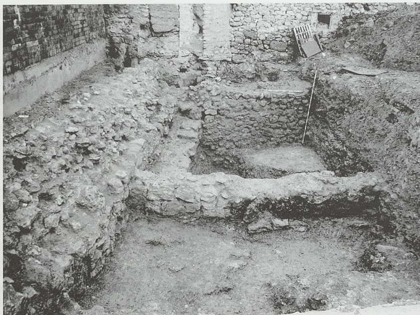
Imagen final de la excavación realizada junto a la Puerta Salinera. A la izquierda se puede apreciar la cimentación de la muralla, que parte de la torre circular, localizada al fondo de la imagen.
