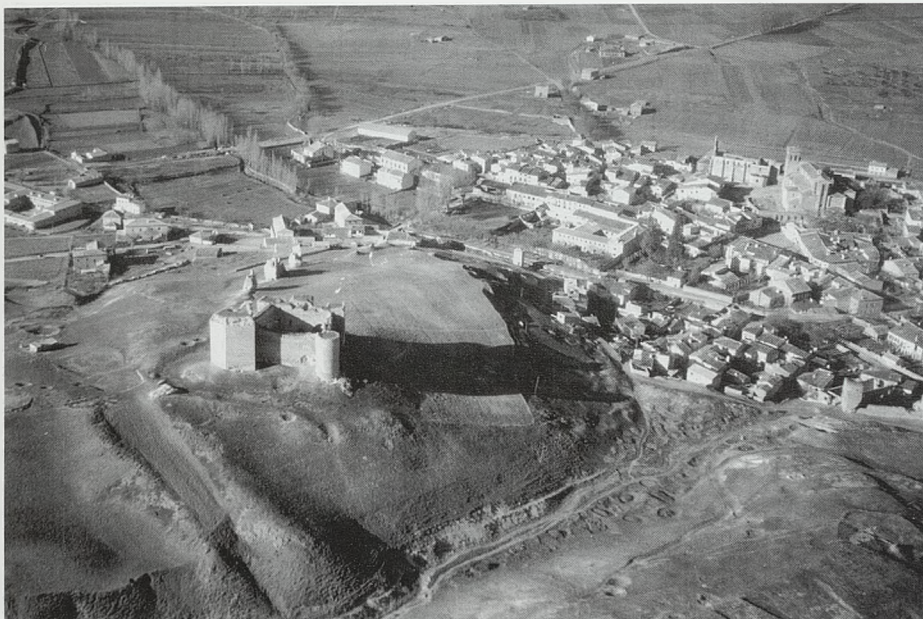
Imagen aérea oblicua tomada desde el Este del conjunto fortificado de Cifuentes (año 1955). Se puede observar en primer término el castillo y su foso, el albacar y las torres del sector de la Puerta Salinera, en el recinto 3 del conjunto. CECAF, Ejército del Aire.
