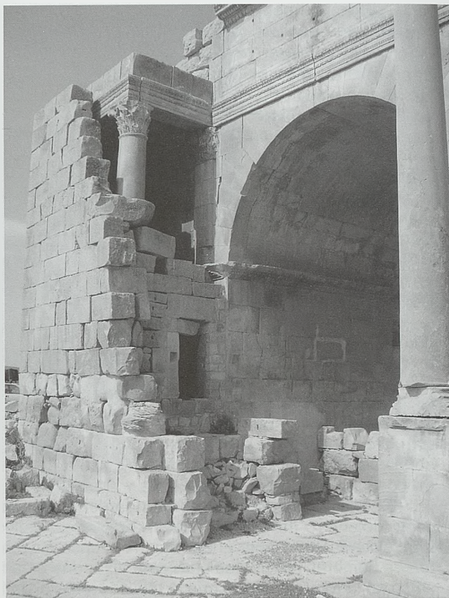
Haidra, vista de la puerta de acceso a las cámaras
