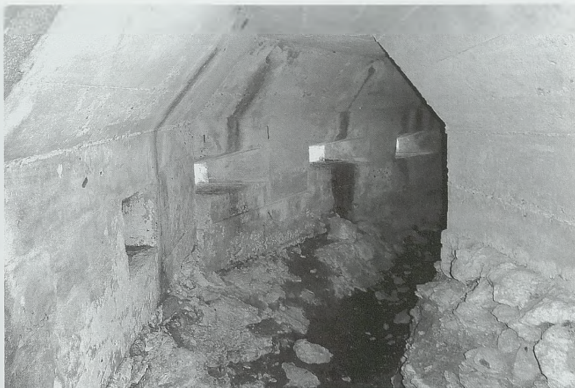
Fig. 5. Vista interior del fortín de Sámano (Castro Urdiales)
