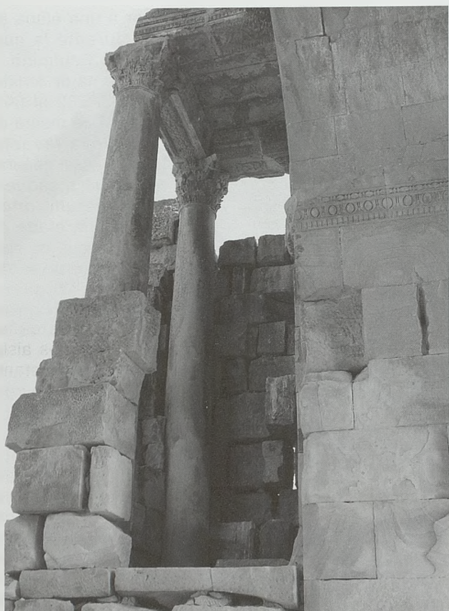
Haidra, detalle de las cámaras añadidas
