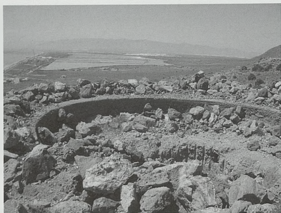
Batería I, Norte. Restos del emplazamiento del cañón Vickers 152 mm, en Cabo de Gata. Se observan los restos de tornillería del anclaje del cañón al suelo
