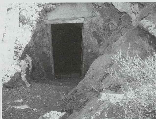
Entrada al refugio subterráneo por el Oeste, bajo las baterías de Castell del Rey
