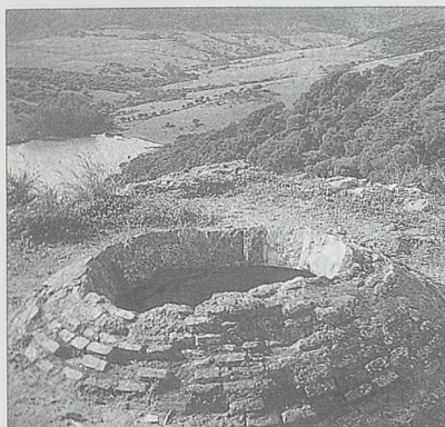
Extradós de la bóveda de la estancia superior de la torre de Botafuego, que aflora en el terrado.
