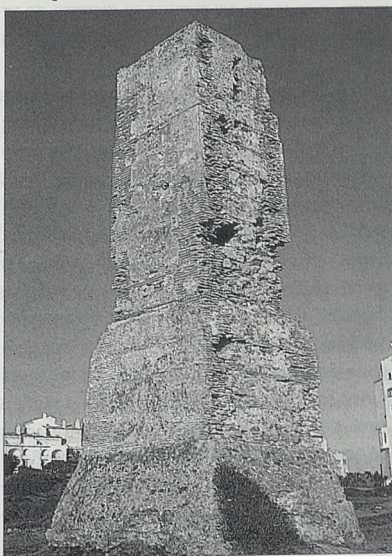
Marbella (Málaga), torre Ladrónes
