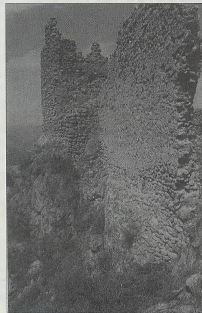
Al fondo se observa la torre del homenaje.
