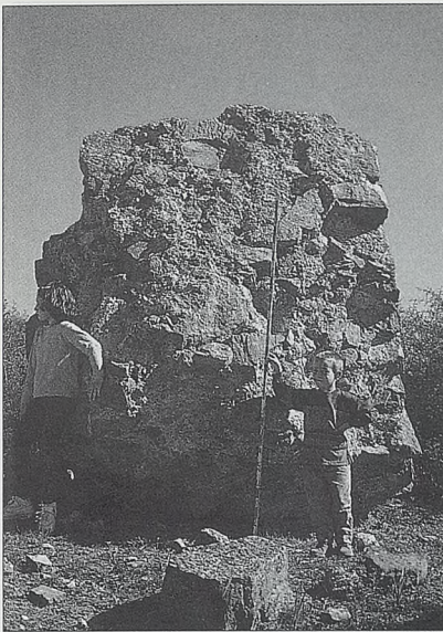
La voladura de la torre de Punta Carnero dispersó sus fragmentos por la ladera sobre la que se alzaba. El de la ilustración mide 7 m 3 .
