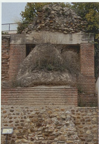
Figura 4. Resto de la tapia de tierra conservada en la torre A.1 junto a la Puerta de la Tostonera antes de su última restauración. (E. Herrero, 2010)
