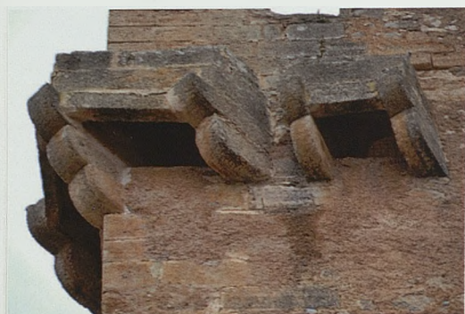
Figura 9. Matacanes angulares (detalle)
