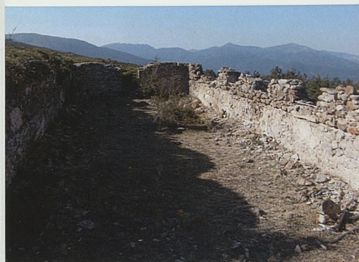
Figura 19. Interior del cuartel de la Fuente del Infante. Nótese el empleo de fábricas más sencillas que las de las obras del puerto de Guadarrama. El techo era de chapa, no blindado
