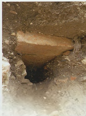
Figura 10. Detalle de uno de los mechinales del lienzo B.8 en el que se puede ver la colocación de los ladrillos formando dintel para permitir la extracción de las agujas. (C. Fernández, 2012)
