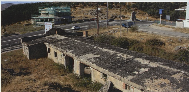
Figura 4. Vista superior del cuartel tomada en 2015. Se aprecia la larga nave central con las alas añadidas, el techo blindado a dos aguas y la estrecha fachada monumental. Casi toda la obra está en una zanja
