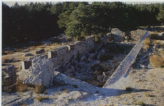
Figura 16. El cuartel III en 2015. Se aprecia el corte realizado a cota uniforme en la obra para extraer la armadura metálica que soportaba el techo. Los bloques caídos alrededor son fragmentos de hormigón en masa
