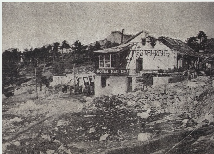
Figura 20. Fotografía del hotel La Peña publicada en abril de 1937 en Vértice. Tras sus ruinas se aprecia el cuartel II en construcción y junto a la chimenea torcida, lo que parece ser un nido de ametralladora
