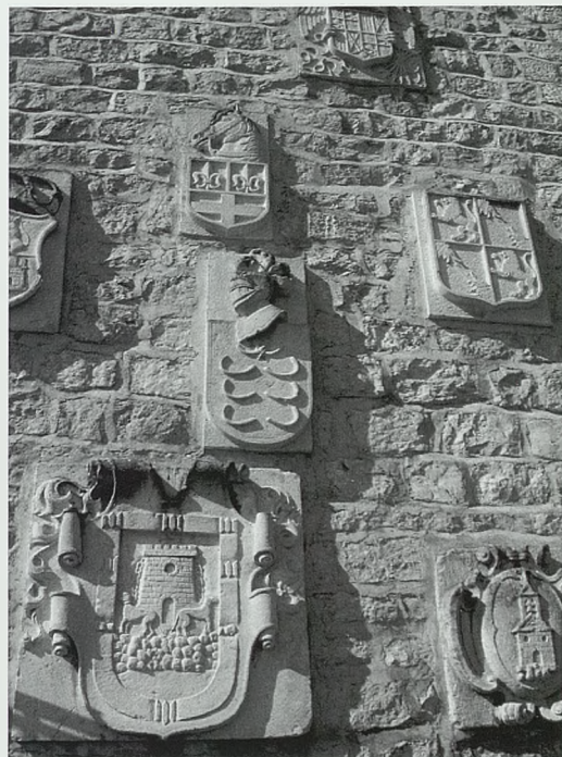
Figura 6. Escudos reutilizados en el muro de la hostería. Estado actual
