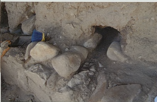
Figura 18. Intradós de la muralla. La fábrica de tapial se encuentra muy erosionada en su base y no se ha detectado encintado. Posiblemente se halla perdido o existiría otro elemento que hiciera la función de encofrado, como la alineación de bolos de la imagen (E. Herrero, 2013)
