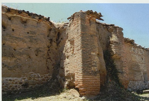
Figura 6. Torre D.1 y lienzo D.2, ambos de tapia de tierra. Situados junto a la Cartuja. (E. Herrero, 2015)
