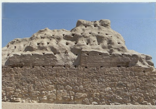
Figura 8. Vista de la cara exterior del muro de tapia B.8 (E. Herrero, 2015)
