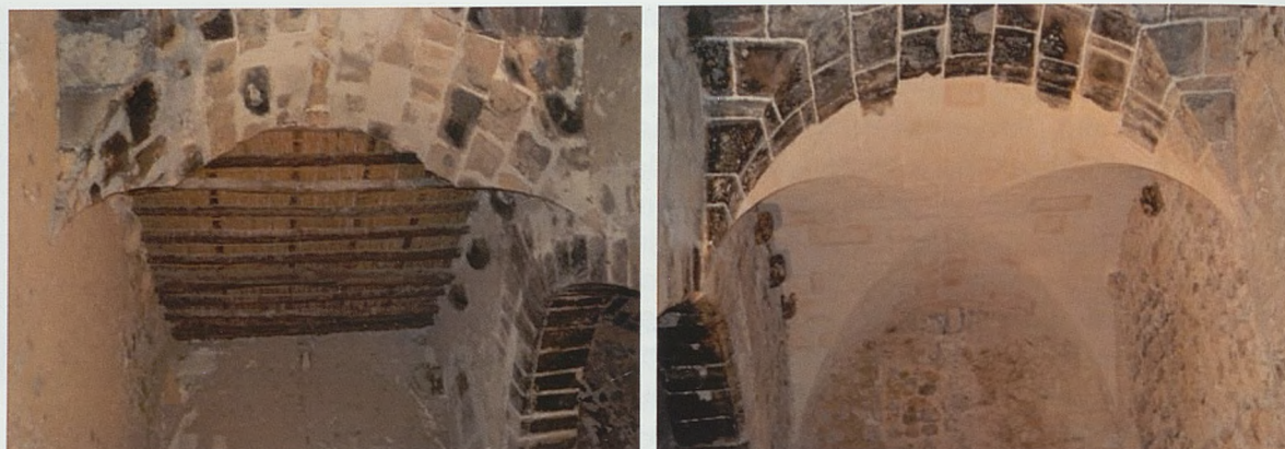
Figura 11. Bóvedas de crucería en fase de restauración
