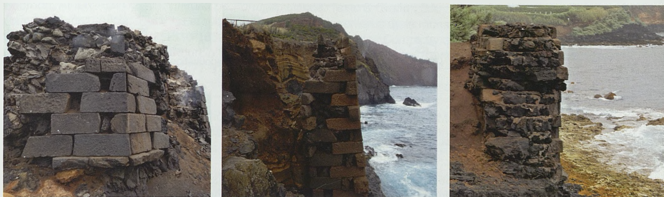
Figura 25. Detalles de la construcción de las fábricas de los fuertes de la bahía da Mina, apreciables gracias a la ruina, que para estos menesteres es muy didáctica: a. sillares de los ángulos con relleno de cascotes del fuerte de Bom Jesus; b. cremallera de sillares colocados prácticamente a hueso o con un mortero muy pobre a modo de estribo interno en el muro nororiental del fuerte de Bom Jesus; c. sección constructiva con los niveles constructivos del frente del fuerte da Greta, donde se aprecian los sillares y piezas perpiañas que anclan el paramento al núcleo.
