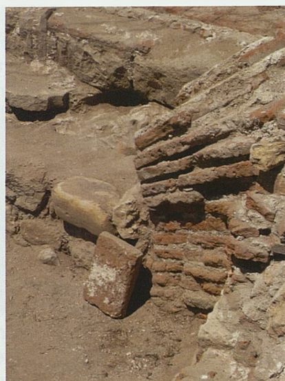
Figura 2. Hoja exterior del tramo de muralla C.2 desenterrado. Aparejada mediante un mampuesto mixto encintado (Reno arqueología. 2013)
