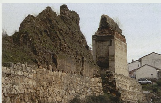
Figura 5. Tramo de muralla en el que se conservan dos restos de tapia de tierra. En primer término el B.8, objeto de este estudio. Al fondo, el B.7, que presenta un encamisado de hormigón. Fotos anteriores a su reciente restauración. (E. Herrero, 2010)
