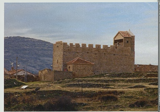
Figura 16. Iglesia fortificada de Valtajeros desde el camino de acceso al pueblo
