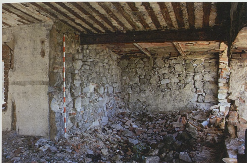
Figura 9. Fotografía del ala añadida Oeste tomada en 2015. Donde está el jalón se aprecia que la pared de la nave original ha sido cortada para ampliar el espacio. Su buena mampostería contrasta con la pobre fábrica del cuerpo añadido. Lo mismo sucede con el blindaje del techo, con abundantes carriles en la obra primitiva y muy ligero en el anexo: 20 centímetros de hormigón en masa soportados por bovedillas apoyadas sobre dos carriles
