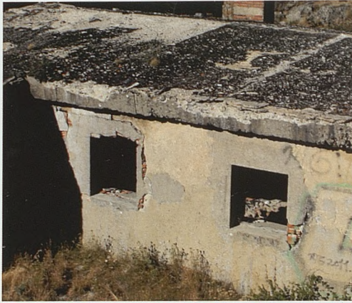
Figura 7. Detalle de las ventanas grandes de la nave central en la que se puede ver la brecha irregular picada en la pared original realizada para abrirlas y el plastón de enlucido gris, diferente al original color crema
