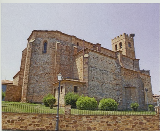
Figura 10. Iglesia de Santa María la Real de Ólvega. Despunta su campanario con terraza almenada
