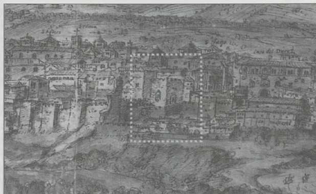
1. Vista de Guadalajara. Antón Van den Wyngaerde, 1565. Enmarcada con línea discontinua torre nº 3.
