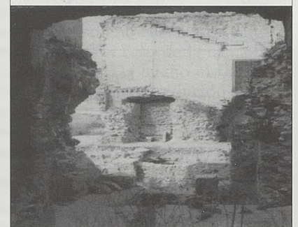
2. Vista del vano y torre desde el exterior
