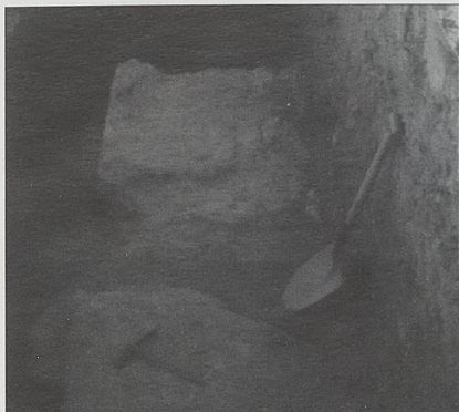
1. Cata d. Detalle del muro de tapial localizado -torre d-
