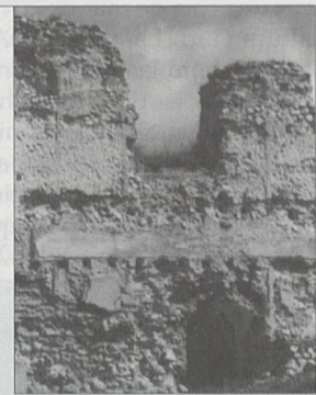
1. Detalle del muro, fachada exterior.
