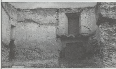
2. Vista de la torre desde el interior del recinto
