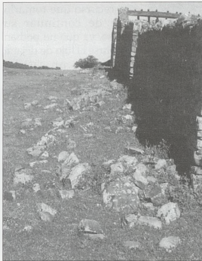
Fig. 8. Cimientos del muro sur
