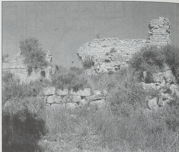
Vista de los dos lienzos de muralla y de la fachada del recinto interior del castillo. En cuanto al lienzo exterior de muralla, el fragmento a la derecha de la toma es original, pues conserva la argamasa que traba los mampuestos, mientras que el que está a la izquierda, en el centro de la toma, parece ser un montaje moderno a partir de mampuestos sueltos, pues aparecen asentados en seco, sin trabar con argamasa.
