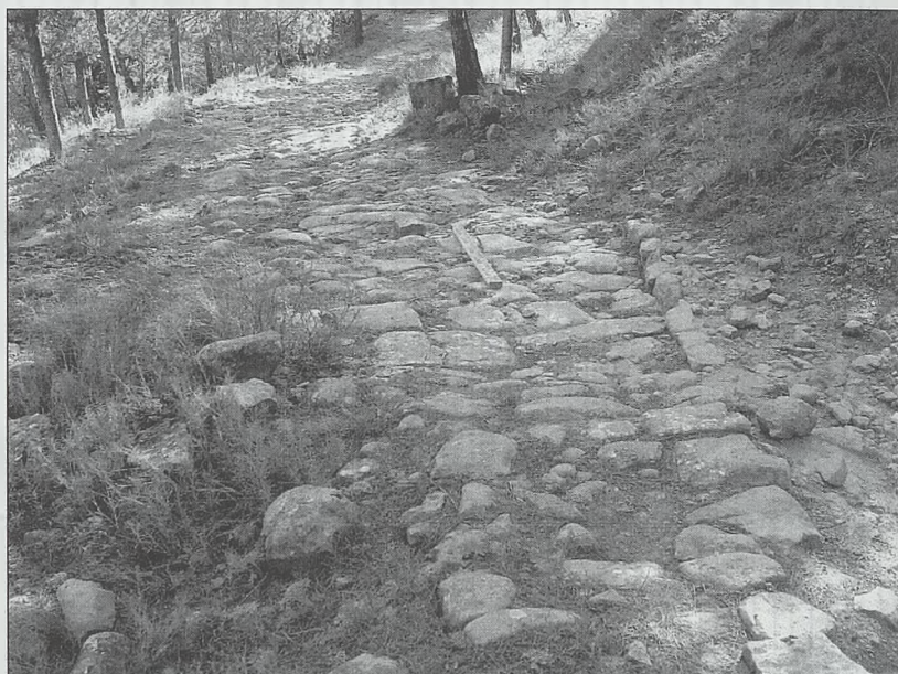
Por la ladera oriental del monte de San Miguel asciende un camino empedrado que lleva hasta la ermita. Es, posiblemente, medieval, y sería el acceso al castillo pasando por el terreno donde se sitúa la ermita, ya que discurre por las zonas menos abruptas. Se conservan cuatro tramos empedrados con claridad. Pudo ser más ancho, al menos en algunos tramos, pues aparece cortado al aterrizar modernamente el monte. Presentan unos bordillos en el lado en que la ladera asciende, seguramente para evitar deterioros del empedrado por arrastre pluvial. Es el segundo tramo que se conserva de arriba a abajo. Toma desde arriba.
