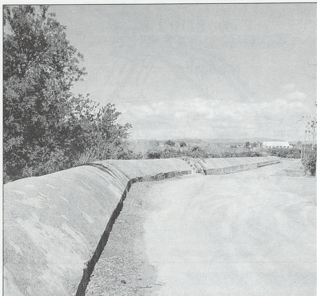
Fig. 7. El nuevo cauce por el «Camí dels Masos»
