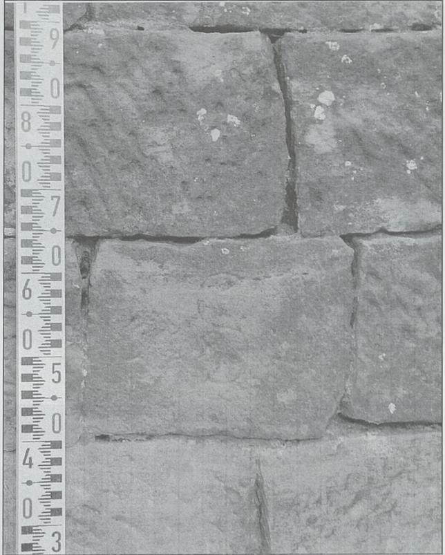
Marca de cantero (S) en un sillar de la torre angular sudeste. Línea interior (superior) de muralla. Hay allí tres sillares con esta marca
