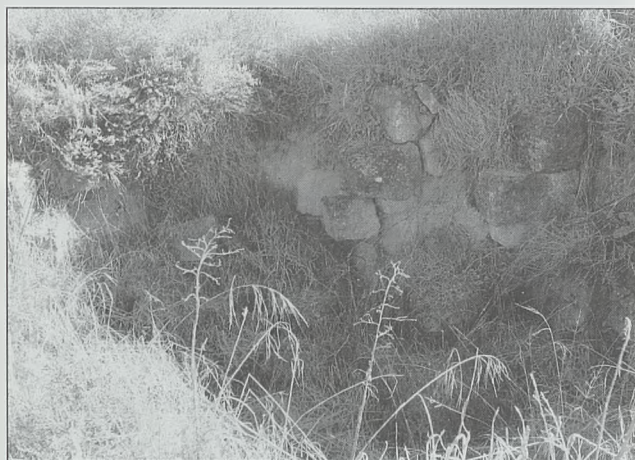
Acceso al aljibe. Fue cerrado por el ayuntamiento. La profundidad, hasta la superficie de las piedras exteriores, es de unos 4,5 metros y el fondo parece de piedra, pues no manchó de barro la guía topográfica y al tocarlo sonó a piedra. Parece que la longitud de la boca es de unos 60 cms., pero dada la vegetación habría que comprobarlo
