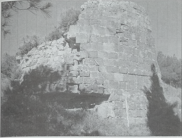
Torre angular sudeste de obra de sillaría. Línea interior (superior) de muralla. Se identifica con el ábside de la iglesia o ermita de San Juan. Pudo tener ambas funciones
