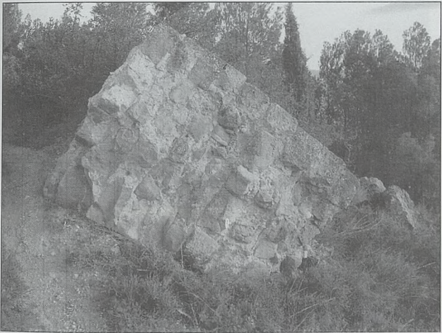
Gran fragmento de muro caído correspondiente a la torre angular sudeste (posible ábside) de obra de sillaría y situado junto a ella. Se aprecia muy bien la obra de grandes mampuestos unidos con argamasa y revestimiento de sillares
