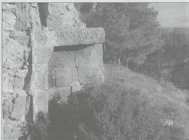
Pequeño espacio practicado en el extremo oriental del lienzo conservado de la puerta de acceso. Orientado perfectamente hacia el sur (el viento dominante es del oeste). No se ve al subir. Puede ser el resto de una pequeña garita de guardia, aunque la tradición sostiene que es un pequeño espacio perteneciente a la sacristía de la iglesia de san Juan del Castillo
