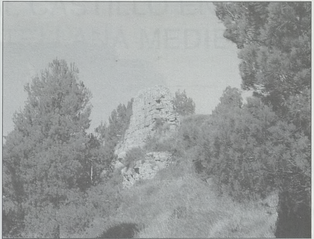
Resto de fachada al occidente de la puerta de entrada
