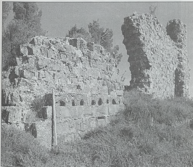
Muro del mismo lienzo que la puerta de acceso. Delimita el recinto interior. Conserva aspilleras. Permite apreciar el sistema constructivo en esta fase: una hilada de sillares regulares unidos con fina capa de argamasa al exterior, con un relleno interior de mampuestos irregulares unidos con una mezcla más grosera de cal y cantos rodados. Fachada sur
