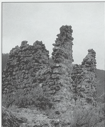
La Torrecica. Detalle de la torre
