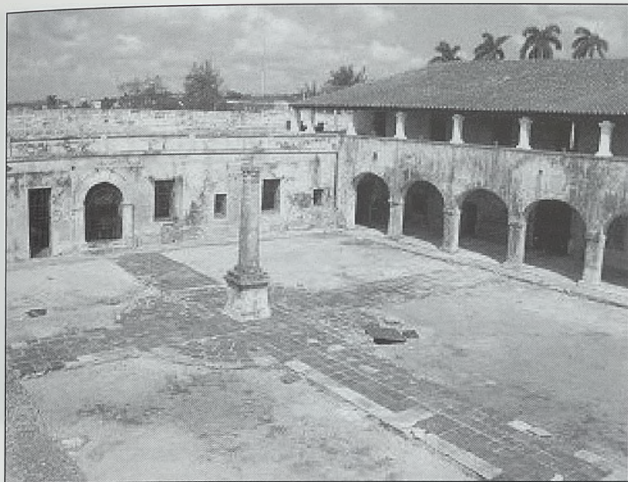
Patio interior del castillo
