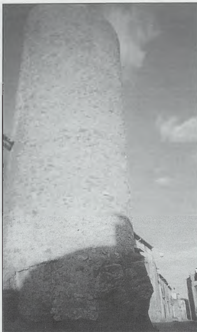
Atalaya de Montejo de Tiermes (Soria). Levantada en la calle principal de la población, en esta imagen se observa la base rocosa sobre la que se apoya, para hacer más difícil los trabajos de minado
