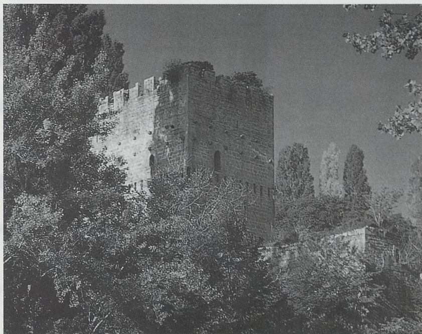
Torre de los Velasco en Espinosa de los Monteros (Burgos).
