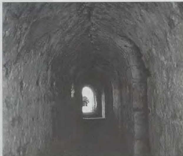
El túnel tras la puerta.
