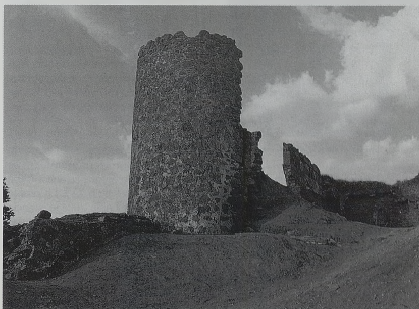
Acceso al castillo tras su limpieza.
