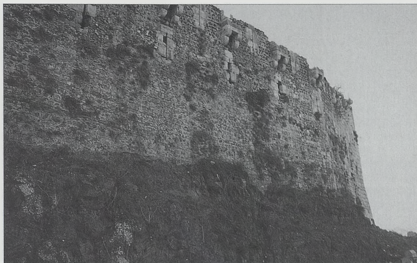
Muralla exterior con ladroneras.
