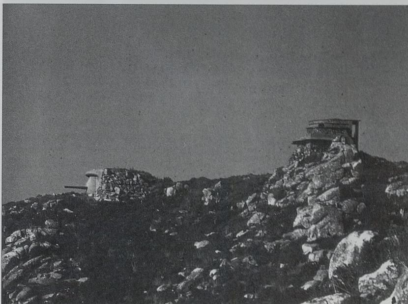
Casamata armada con un cañón de costa de 15 cms. Munaiz-Argüelles y sobre ésta el búnker de control y tiro y observación. Batería de Cabo Sillero. Baiona (Pontevedra).
