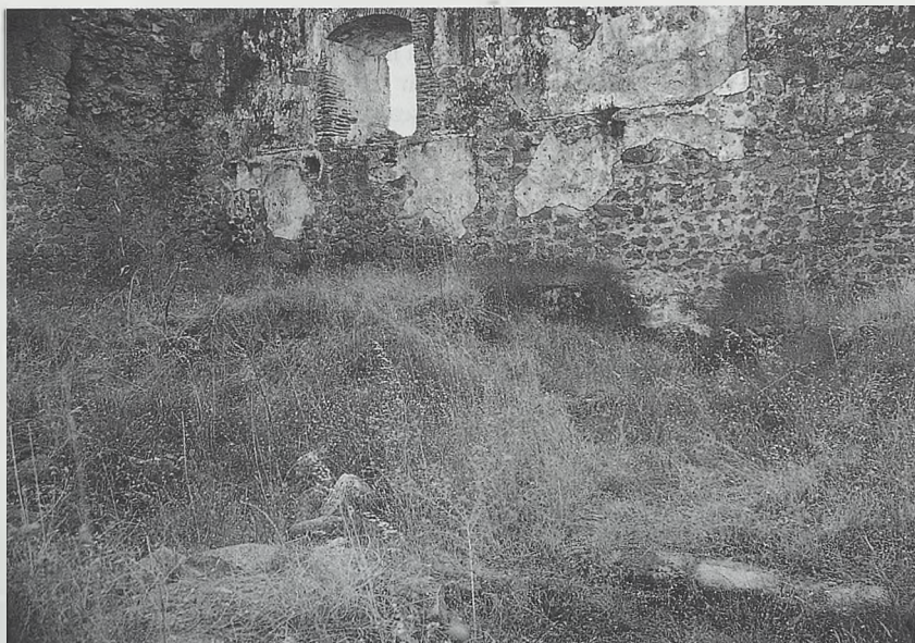
Crujía este, antes de su excavación.
