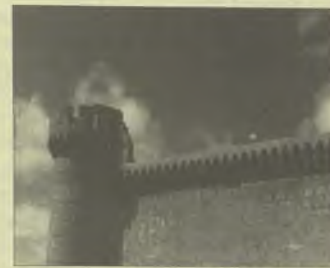
Fachada este restaurada
