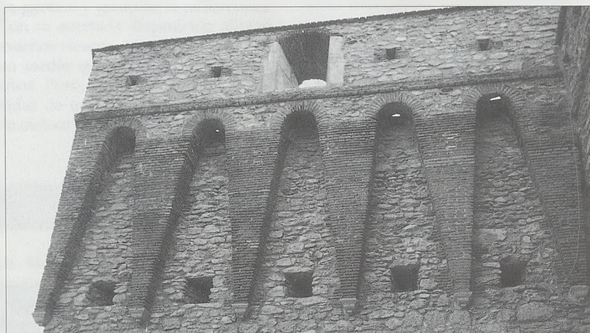
Detalle del coronamiento de una torre
