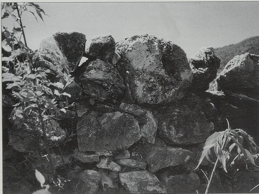
Fotografía nº 10. Fragmento de la fábrica del muro norte.
