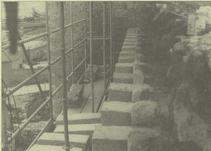
Fachada norte en proceso de restauración.
