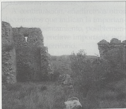
Zona de la torre, antes de la limpieza.
