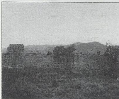
Sector siguiente después de la limpieza.
