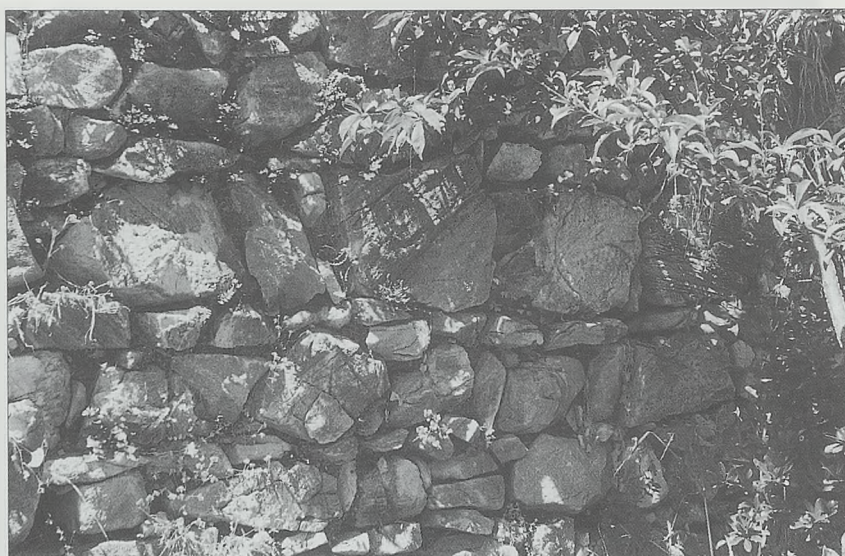
Fotografía nº 12. Detalle de la fábrica original, muro oriental.
