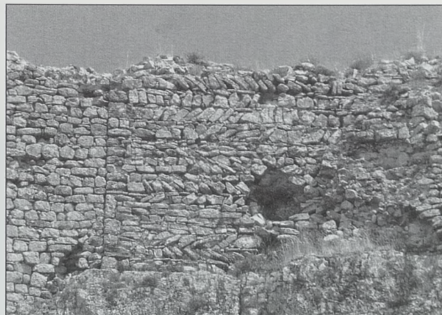
Albarca del castillo de Atienza. Detalle del aparejo altomedieval conservado en un paño
