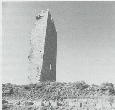
Imagen de la torre del Homenaje del casti- llo de Santacara, tras las obras de la segunda intervención
