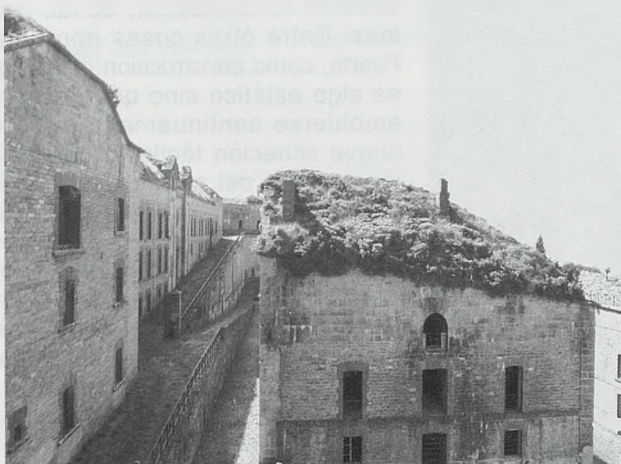
Edificio de Pabellones. (Foto J.V. Valdenebro)
