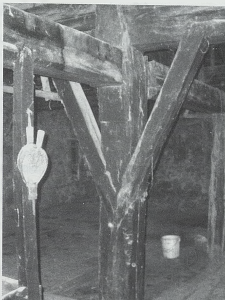
Arranque de la estructura piramidal de la vigería del desván o ganbara
