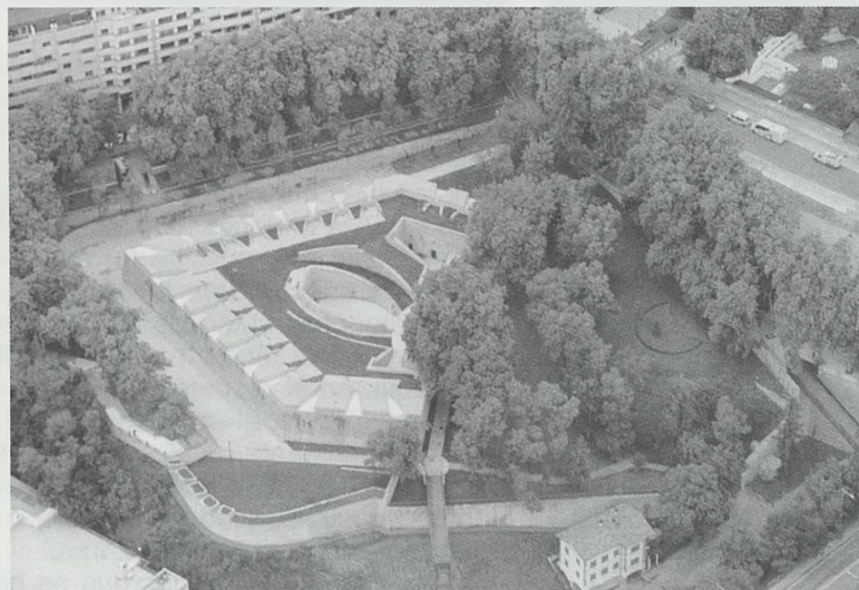
El Fuerte de San Bartolomé convertido en el Centro de Interpretación de las Fortificaciones. Imagen de 2011
