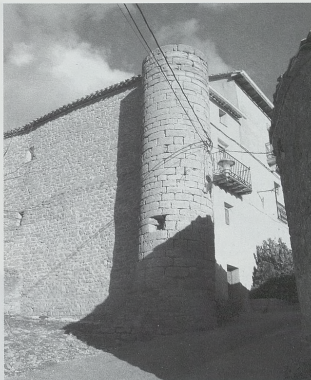
Cubo sudoccidental del recinto monástico y rampa de acceso a la iglesia
