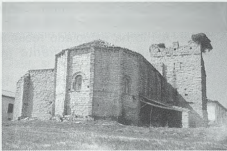
Vestigios de la encomienda de Cizur Menor con anterioridad a la restauración efectuada por el Gobierno de Navarra. Fotografía cortesía de la familia Ezpeleta. Abril 1967
