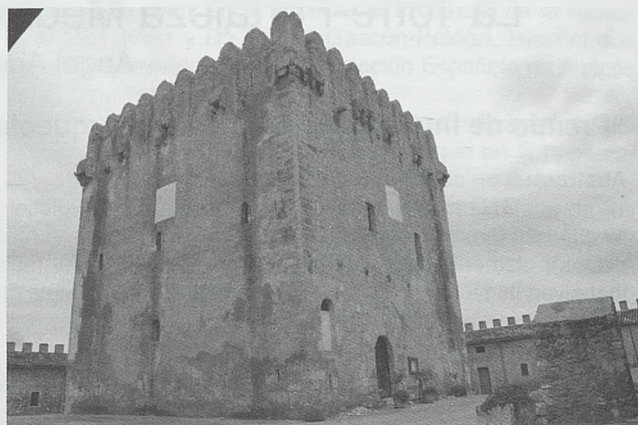
Aspecto general que presenta la Torre-Fortaleza
