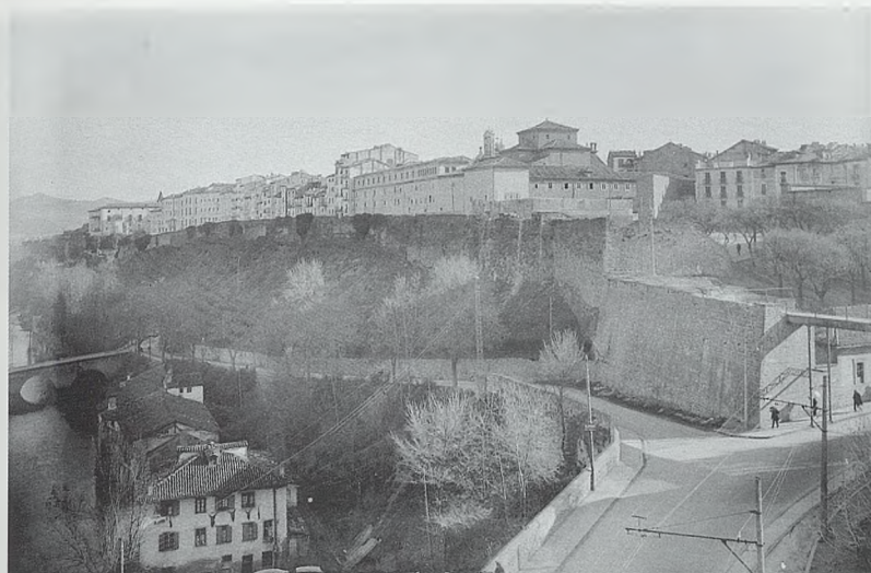
Vista del Portal Nuevo con la pasarela metálica y parte del frente de la Rochapea. AIPV
