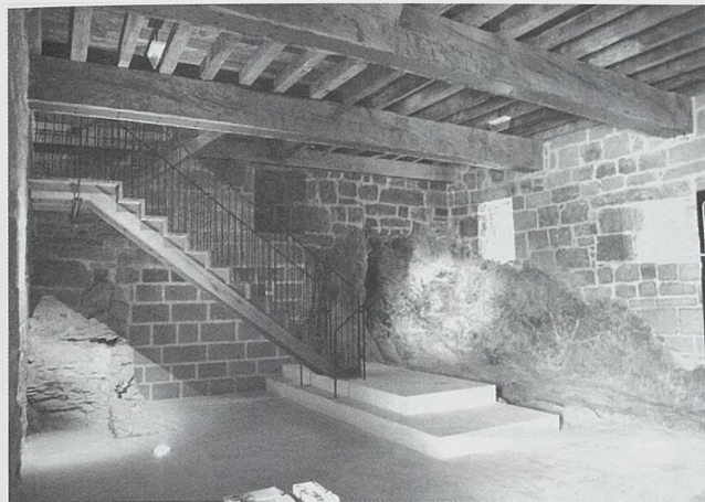
Interior de la torre, planta baja
