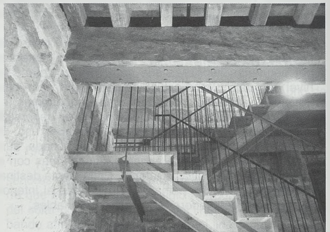
Estructura de la escalera
