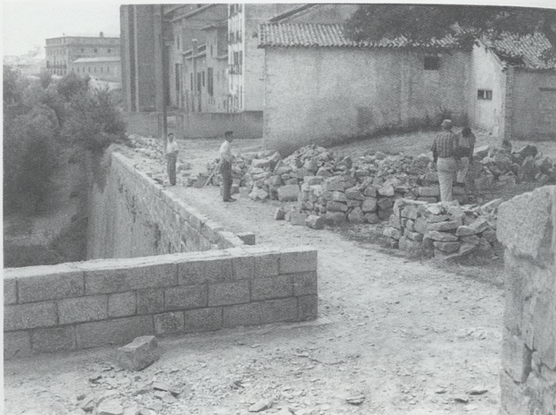
Obras de restauración en el baluarte del Redín de 1955. AMP
