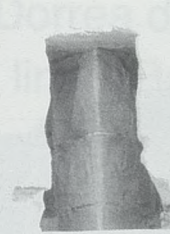
Cañonera frontal con doble derrame de Logroño
