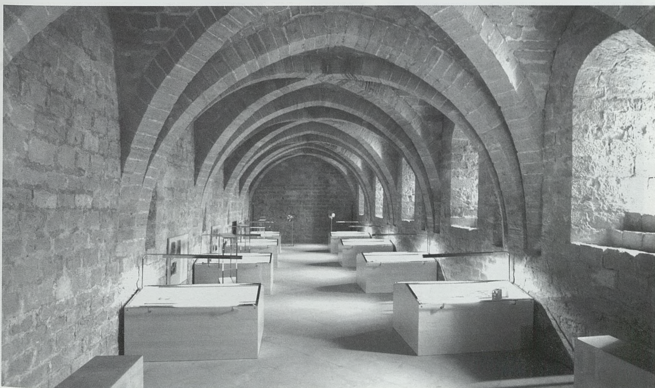
Cripta gótica, actual sala de exposiciones
