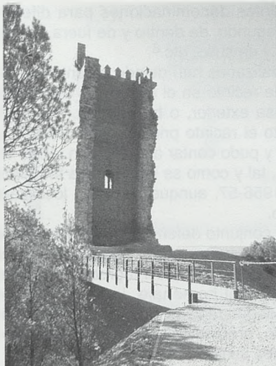
Imagen de la torre del Homenaje del casti- llo de Santacara, en 2001, tras las obras de la segunda intervención
