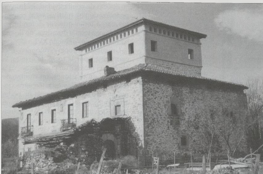
Torre de Murga (Respaldiza-Álava). Obsérvese el arco de medio punto entre dos cubos, bajo la ruínosa tejavana
