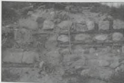
Fig. 2 Paramento de mampostería encintada de tipo cajeadá
