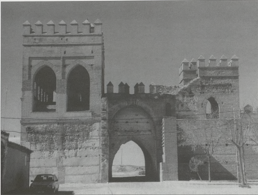
Interior de la Puerta de Cantalapiedra
