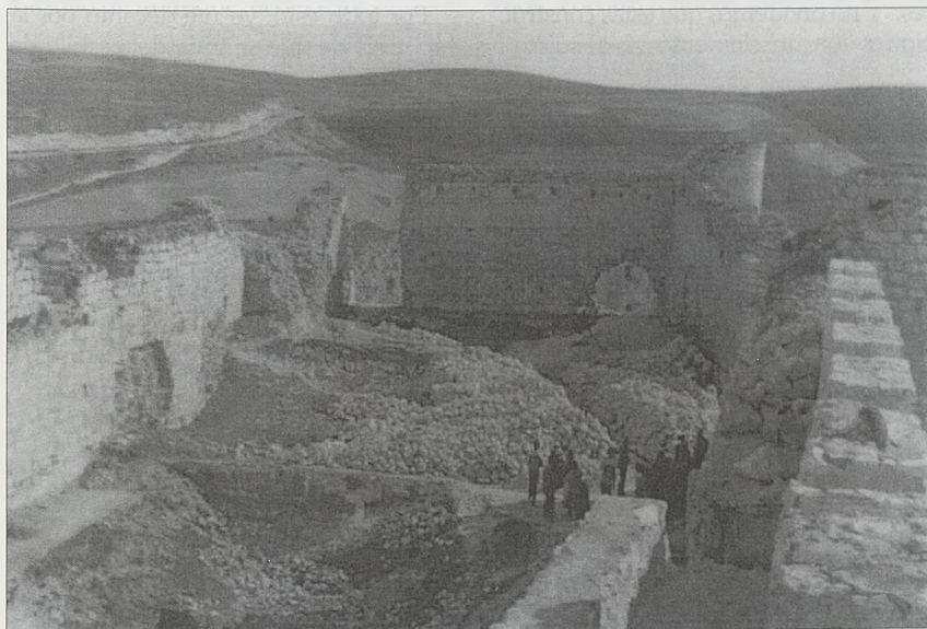
Fig. 6 Detalle desde el adarve del espacio interior de la zona de
