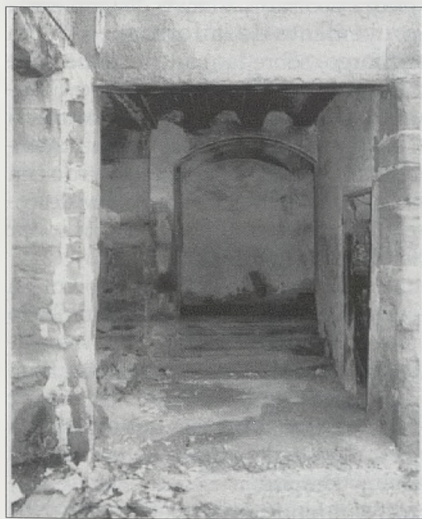
Lámina 8. Primer tramo de escaleras
