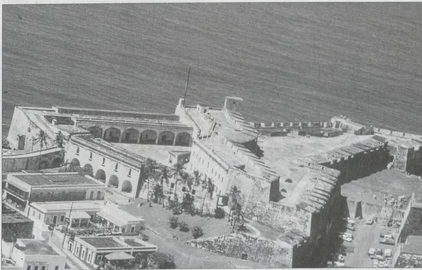
Detalle interior de la muralla noroeste del castillo del Morro
