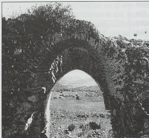
Puerta de acceso (sala 1). Vista desde el interior. Se observa la doble arcada y la forma de herradura apuntada del arco exterior
