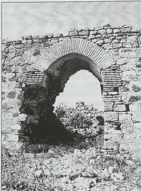
Puerta de acceso (sala 1). Vista desde el exterior
