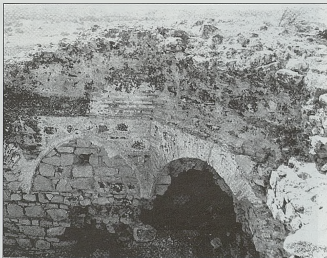
Vista parcial de la sala 10. Se aprecian los restos del arranque de la bóveda a 8 trompas
