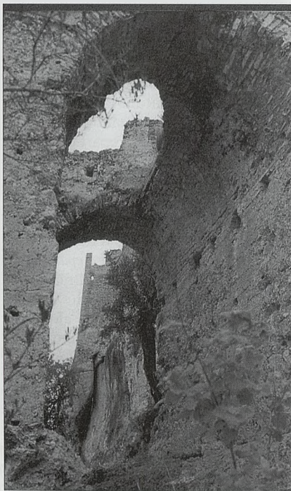
Castillo de Corbera. Arco de la coracha y torre de la muralla
