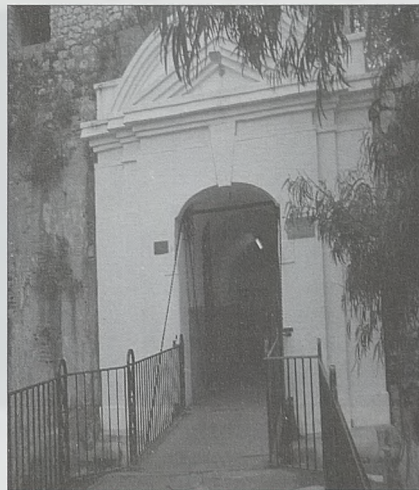
Puerta de Tierra (Land Gate), obra de Bravo de Acuña reformada exteriormente por J. Montessor hacia 1751
