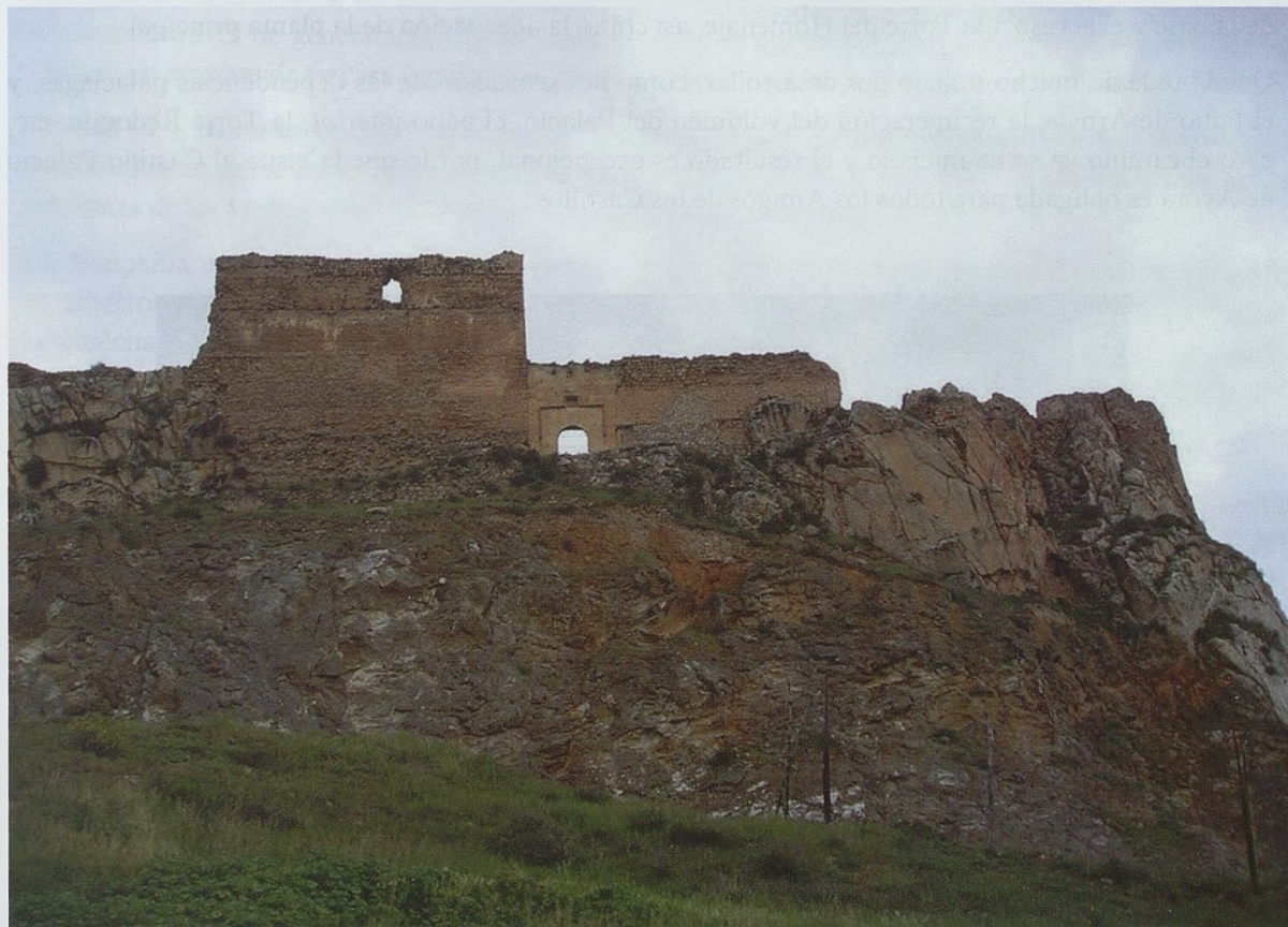
Figura 1 Lienzo Sur antes de la Restauración
