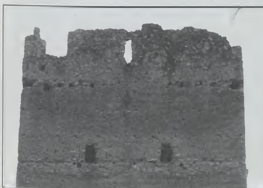
Fig. 5. Torre de Mussa (Benifaíó). Vista frontal de la zona superior de la cara oeste. Aparecen claramente los mechinales de las vigas de los cadalsos de ángulo y, a la izquierda una de las puertas de acceso
