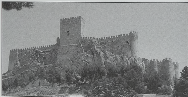
Fachada occidental del castillo de Almansa
