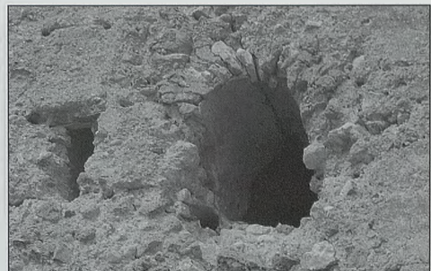
Fig. 23. Torre de Montroy. Vista de detalle del vano de acceso al dispositivo lígneo de defensa vertical situado sobre la puerta; obsérvese en su base, a la izquierda, uno de los dos mechinales para insertar el suelo
