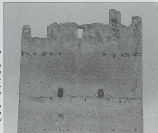
Fig. 6. Torre de Mussa (Benifaíó). Vista frontal de la zona superior de la cara sur. Obsérvense los mechinales de las vigas de los dos cadalsos de ángulo y, a la izquierda, una puerta de salida al dispositivo
