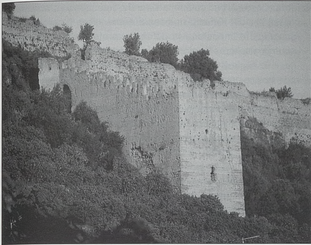
Torre albarrana i mur d'enllaç doble
