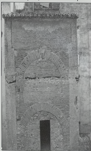
Detalle de la parte posterior de la torre antes de su restauración
