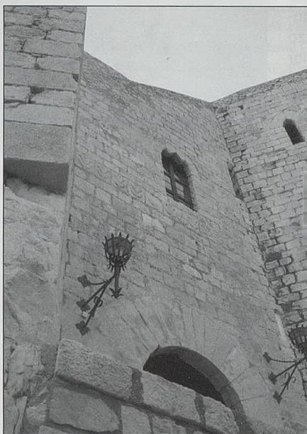
Puerta de acceso al castillo. Obsérvese en la parte superior el friso heráldico. Los profusos cardos aluden al maestre Berenguer Cardona, el emblema de la Orden se encuentra en el centro y el blasón del comendador Banuyls, aparece en la parte central derecha
