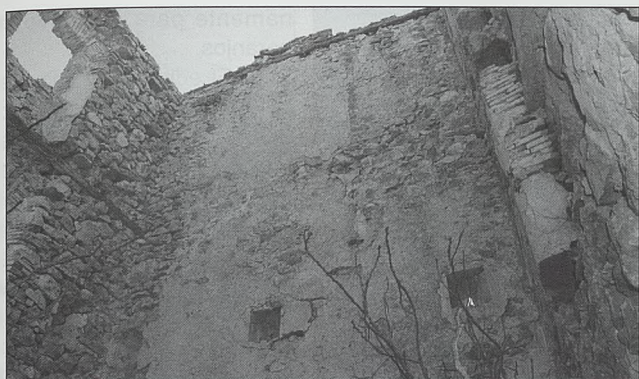
Fig. 19. Torre del Rebollar, Requena. Paramento interior en el que se observan las aspilleras del primer piso. 23 de marzo de 2007
