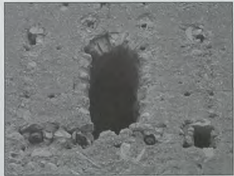
Fig. 20. Torre de Aledua (Llombai). Vista de detalle de los restos de la buharda de defensa de la puerta de la torre. En el centro, el vano de acceso al dispositivo; en la base y el coronamiento, las vigas o los mechinales del suelo y el techo respectivamente
