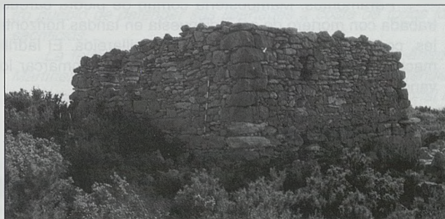
Fig. 31. Restos de la Torre de Alcalá de Xivert 6 de junio de 2006
