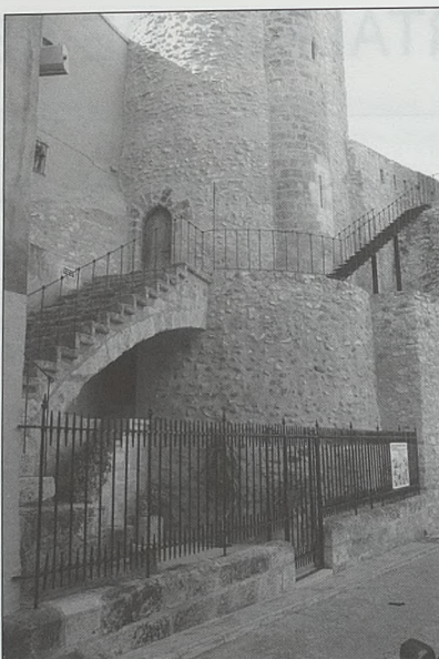
Accesos a la torre de la Cárcel y paso de ronda
