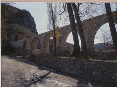
Acueducto de Bejis (Castellón)
