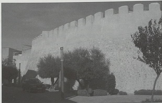
Muros restaurados del castillo de Caudete
