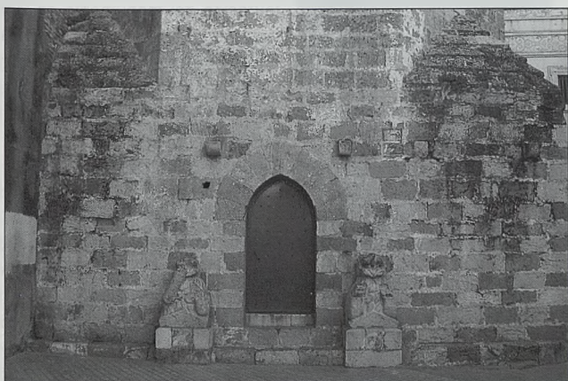
Fig. 8 Torre campanario de base cuadrada
