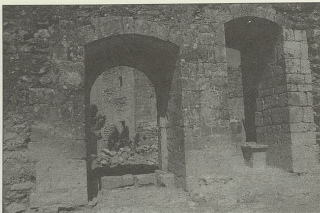
Excavación en el castillo de Chirel
