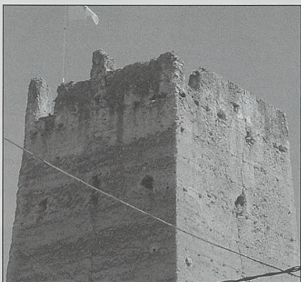
Fig. 25. Torre de Serra. Vista del remate de las caras oeste y sur. Se observan claramente los mechinales y restos de vigas de las buhardas de ángulo por debajo del parapeto; también aparecen muy claras las dos puertas de salida a los dispositivos, situadas a la izquierda de cada lado
