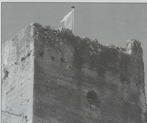
Fig. 28. Torre de Serra. Otra vista del lado oriental, con los indicios de cadalsos de ángulo y el acceso tapiado al del ángulo sureste
