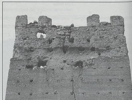
Fig. 14. Castillo de La Pileta de Cortes de Pallás. Vista de la zona superior de la cara frontal de la torre albarrana. En el espacio situado entre las dos almenas centrales se dispondría el cadalso, apoyado sobre los tres mechinales claramente apreciables. En el centro, un poco descentrada, la puerta de salida al dispositivo, tapiada con mampostería. Los espacios entre las almenas laterales aparecen también parcialmente tapiados con mampostería
