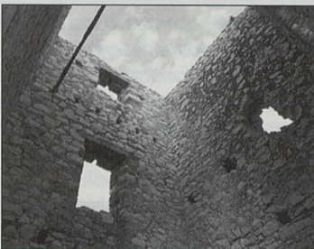
Fig.11. Interior de la torre de Santa Magdalena de Polpis
