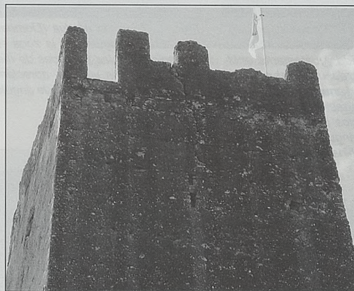
Fig. 29. Torre de Serra. Vista del lado norte con los mechinales y vigas de los suelos de los dispositivos ligeros de ángulo y, a la izquierda, el vano de acceso a la buharda del ángulo noreste
