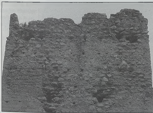
Fig. 21. Torre de Aledua (Llombai). Zona superior del costado suroeste. A ambos lados se aprecian bien algunos de los mechinales, muy deteriorados, de los dos cadalsos de ángulo, así como los restos de alguna de las vigas; en la zona deprimida de la izquierda del parapeto se situaría una de las puertas
