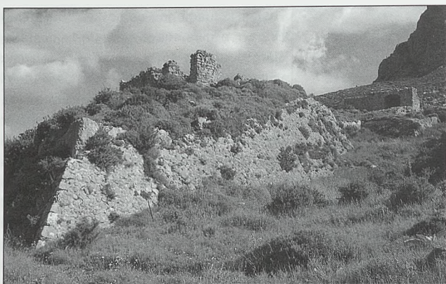
Fig. 4. Foso y baluarte del sur, uno de los mejor conservados, sobre él se alzan los restos de un edificio de grandes dimensiones.
