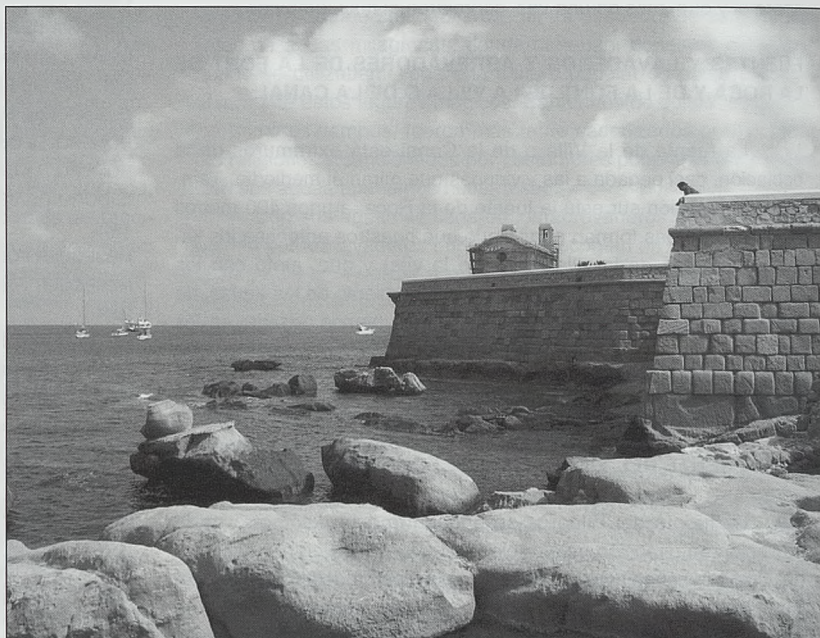
Vista de la fortaleza de la Nueva Isla de Tabarca
