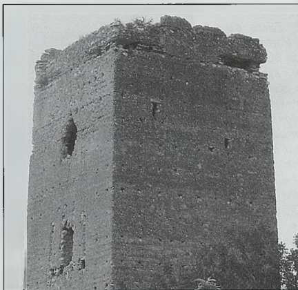
Fig. 19. Torre de Aledua (Llombai) Vista desde el este. En los ángulos de la zona superior aparecen los indicios de las buhardas de madera, con varios mechinales bien visibles, apreciándose claramente la inexistencia de mechinales de ángulo
