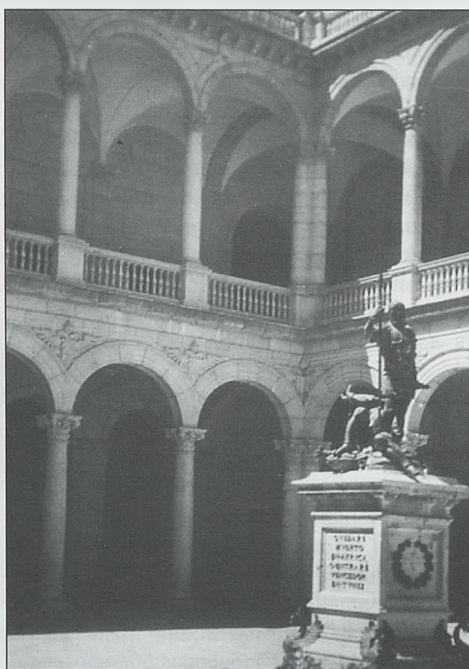
El patio central en la actualidad. La estatua del emperador Carlos V, reproducción del original, obra del veneciano Leoni Leone, preside nuevamente el empaque del tantas veces destruido y renacido Alcázar
