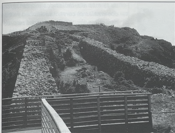
Camino cubierto y plaza de armas
