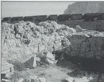
Restos del castillo de Santa Bárbara, que cerraba por Levante la Línea de contravalación, ante el Peñón de Gibraltar, con búnkeres superpuestos
