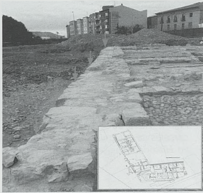
Fig. 5. Restos de la fachada interior del Tribunal de la Inquisición
