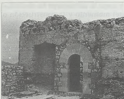
Fotografía 3. Aspecto de una torre antes de la restauración.
