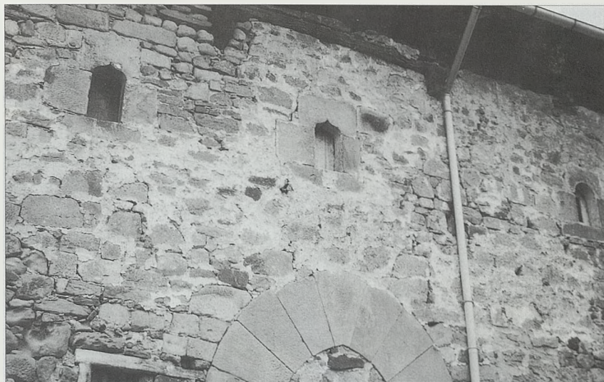
Casa-fuerte de Goyenengoa. Detalle de la galería de ventanas renacentistas y del acceso a la cuadra, en la fachada sur.
