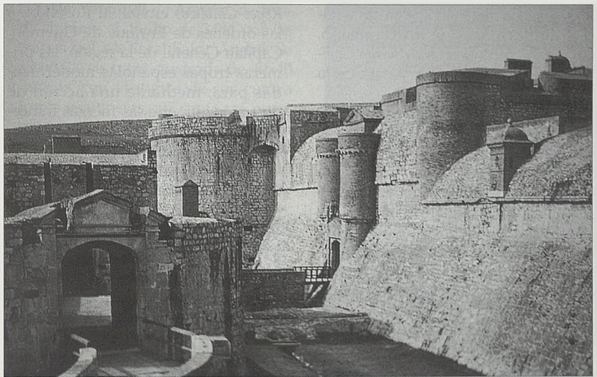
Lado sur. Revellín de la entrada, talud de la escarpa, foso, puente levadizo y puerta sur fortificada.
