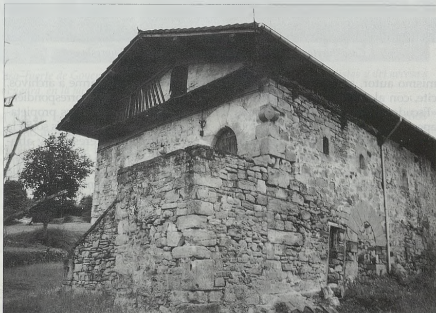
Casa-fuerte de Goyenengoa. Vista general desde el sureste. Fotografías deñ autor.
