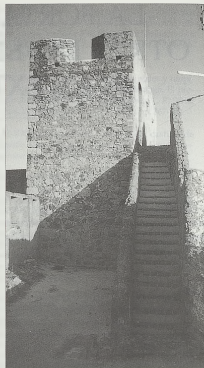
Detalle de la torre principal
