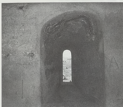
Fotografía 7. Ventana saetera en el flanco norte.
