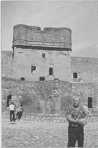
Ante el este de la torre del homenaje se levantan dos caballeros unidos, con plataformas para cañones, y un foso a ras de suelo, que aislaba el reduto, al que los sitiados podían retirarse, si el resto de la fortaleza caía en manos del enemigo.
