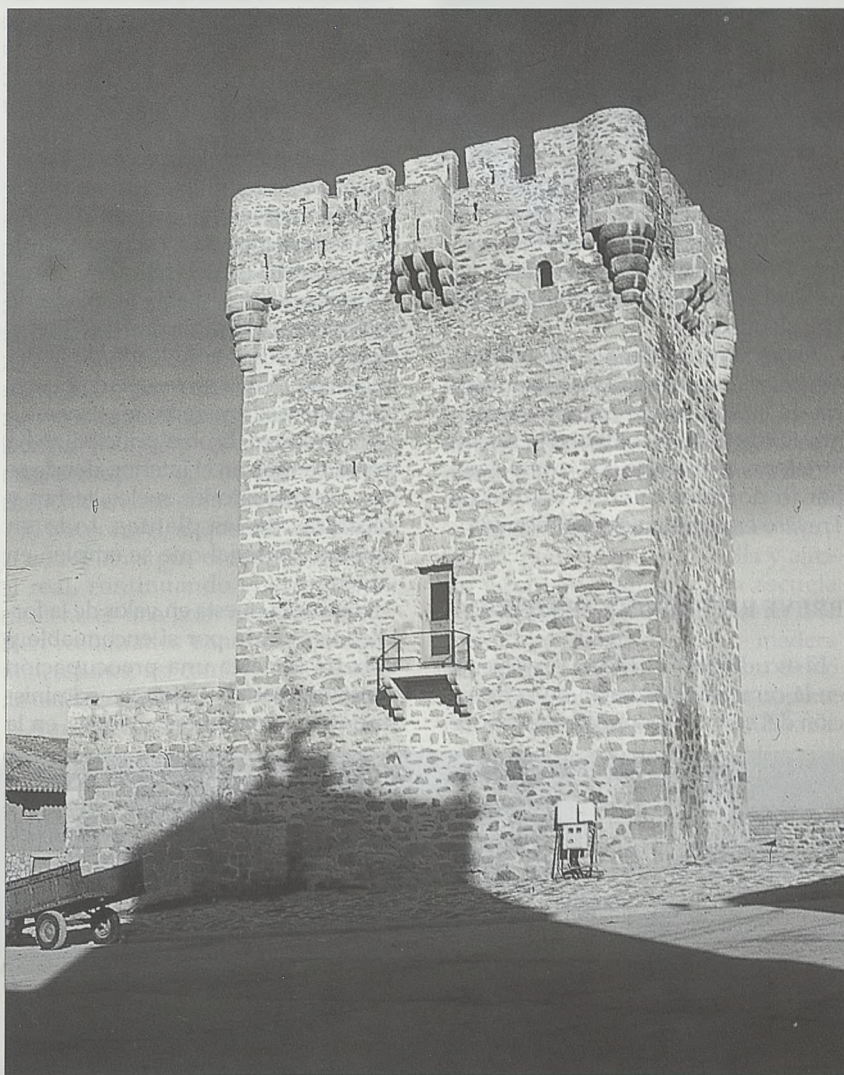
Torre de Sobradillo: frente sur. Obsérvese el aljibe, al este, el balcón inexistente y, al pie del muro, la toma eléctrica que lo afea.
