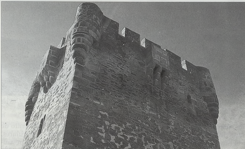
Sobradillo: coronamiento y vanos de la planta superior.
