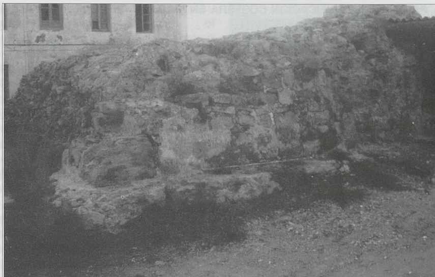
Vista de la esquina SE y plataforma sobre la que se asienta la torre
