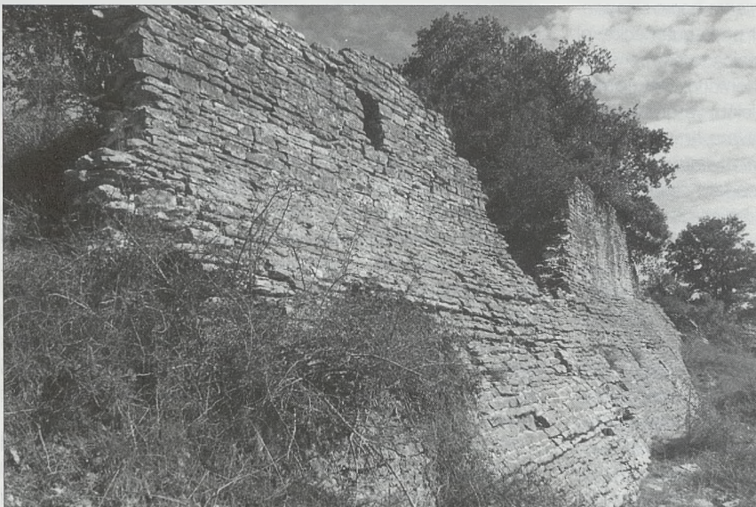
Lienzo que conserva un pasadizo interior transitable
