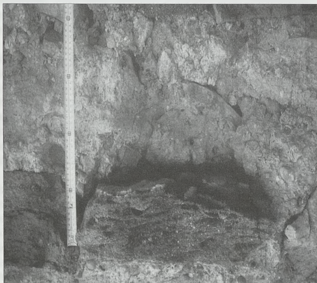
Detalle del único resto del talud original del paramento este
