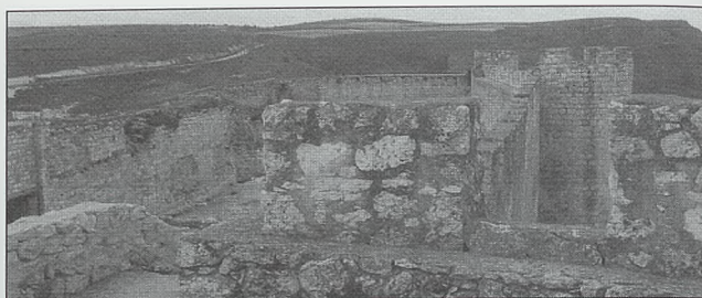
Vista de las almenas superiores, formando un pasillo que recorre todo el perímetro del castillo
