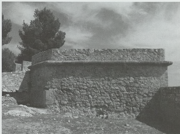
Estado actual de la batería del Este
