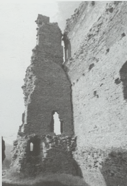
Fig. 12 Paredón norte desde el interior, al borde del desplome (Autor)
