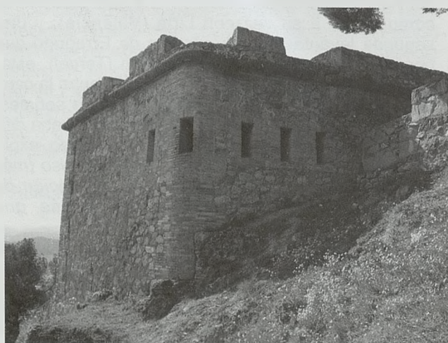
Batería del Este. Se pueden apreciar perfectamente los restos de las cañoneras en la planta superior
