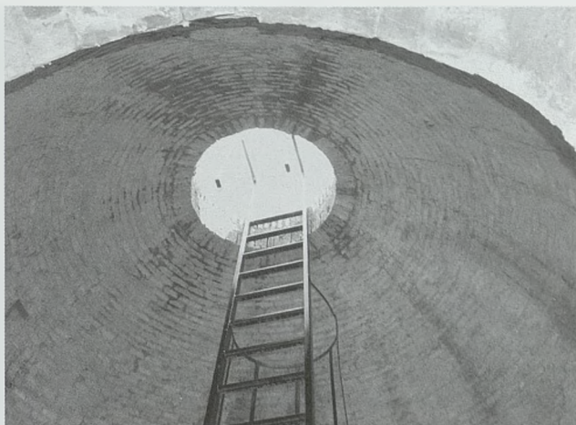
Bóveda y acceso actual a la planta superior del Torreón Través
