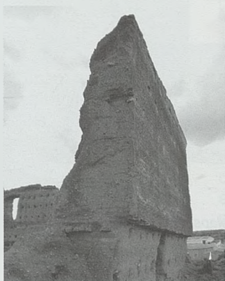
Figuras 4 y 5. Restos de un muro septentrional de la fortaleza. Se puede apreciar la diferencia de sección y la falta de revestimiento en la parte baja del muro. Obsérvese la formación del mechinal con piedras que faciliten la extracción de los travesaños según avanza la construcción. La figura 5 reproduce los mechinales del muro occidental. Se pueden observar las piedras que forman el techo del hueco que dejó el travesaño que atravesaba el muro durante su construcción
