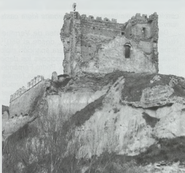
Fig. 6 Vista de la fábrica del castillo, abalconada por los derrumbes del cerro (Autor)
