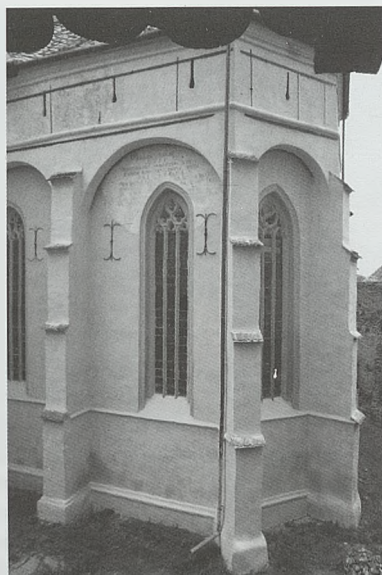
Cabecera de la iglesia de Mosna con arcos paralelos a los muros entre estribos y piso defensivo superior en el que se abren ladroneras rasgadas
