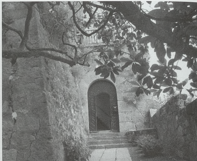
Puerta de entrada al tunel
