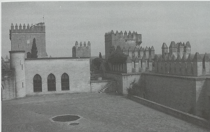
La fachada sudeste, con los tres grandes ventanales apuntados que fueron definitivos. La pequeña torrecilla cilíndrica de la izquierda es una escalera de caracol de acceso a la terraza
