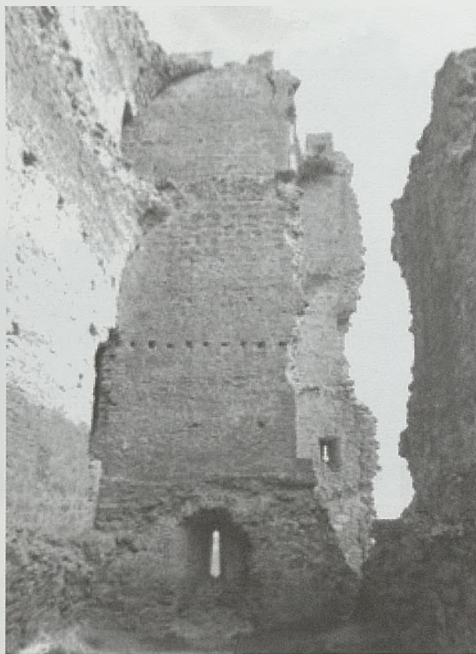
Fig. 11 Paredón sur desde el interior (Autor)
