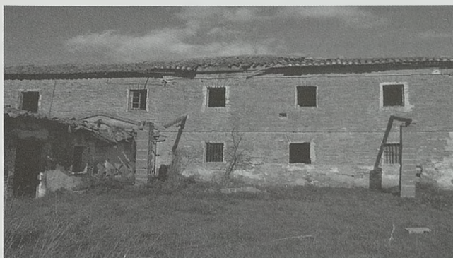
Dependencias del hospital hoy casa de labor en ruinas
