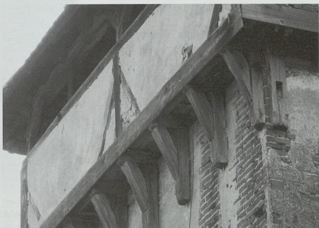
Detalle de los jabalcones que sostienen la estructura lignaria del cadalso de la iglesia de Pelisor
