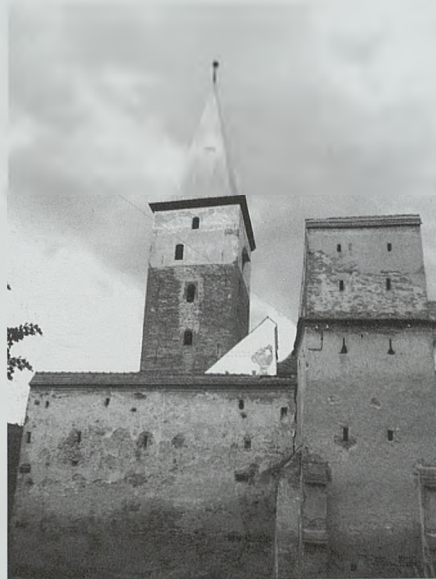
Torre de la puerta entre la muralla y la barbacaña y, al fondo, la torre occidental de la iglesia de Mosna
