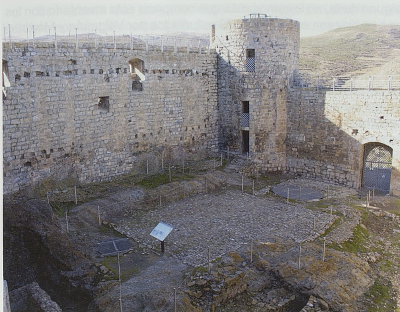
Figura 3. Vista del interior del castillo de Cornago
