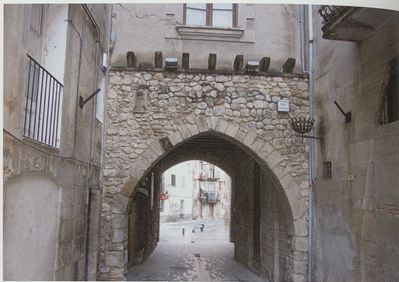
Figura 6. Portal del Romeu en la antigua muralla tardorromana o andalusí de Tortosa, reaprovechada en la Edad Media
