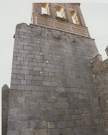
Figura 3, 4 y 5. Obras de emergencia en la Puerta del Carmen y el Cubo de la Mula
