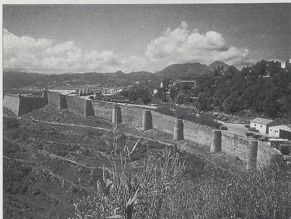
Vista general sobre la vieja muralla del Hacho y baluarte moderno
