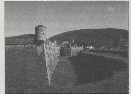
Cara y flanco de un baluarte y su relación con el foso y camino cubierto.
