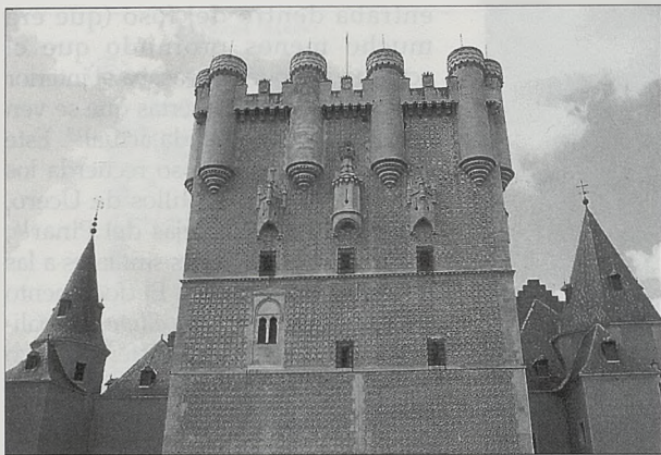
Torre de don Juan II y barrera. Se aprecia la costura de la torre anterior con la ventana de estilo almohade en el centro. Nótese igualmente el derroche imaginativo en los balcones amatacanados y los garitones, decorados con escamas.
