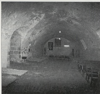
Sala subterránea del Alcázar. En la Guerra Civil se utilizó como capilla y hospital. Al igual que en las galerías, las paredes son de piedra y la bóveda de ladrillo.
