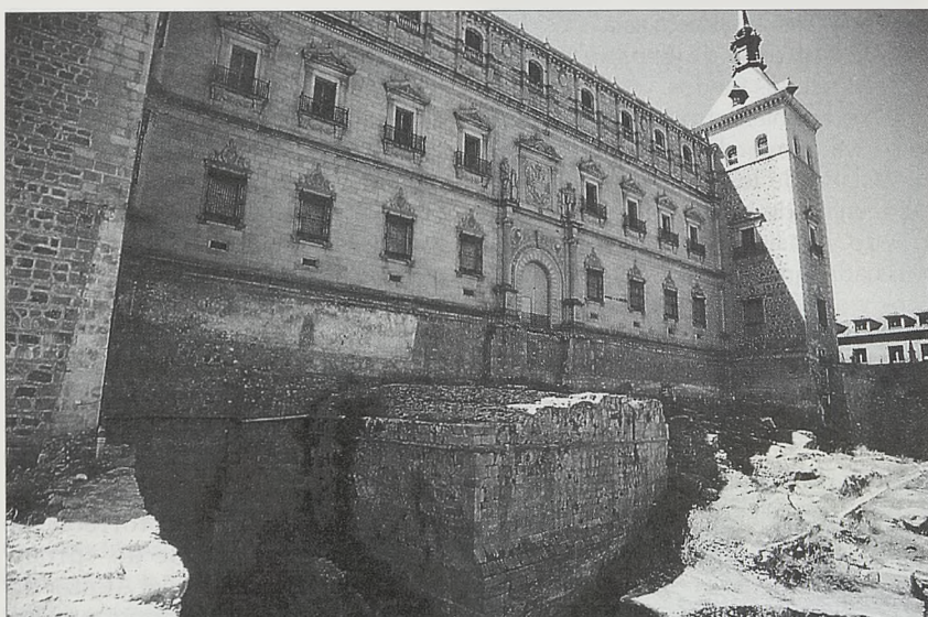
Excavaciones arqueológicas frente a la fachada norte destaca la base de la gran torre cuadrada cuya construcción se atribuye a Juan II.
