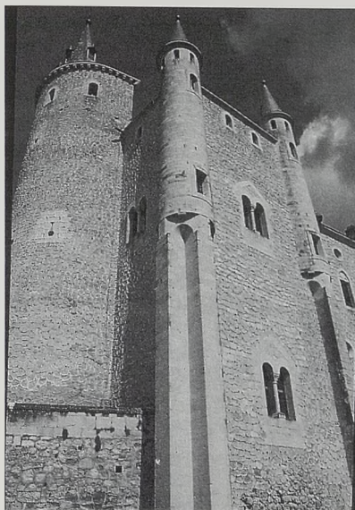
Torre del homenaje. Obsérvense los garitones descansando sobre trompas en contrafuertes y las ventanas germinadas románicas.
