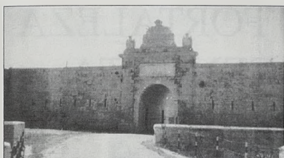
Puerta de la Reina, entrada de la Fortaleza, después de la restauración del escudo.
