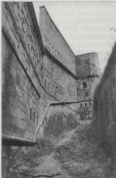
Foso del castillo de La Palma por la parte de tierra. Se aprecian las piedras reutilizadas de los fuertes anteriores encima de la primera moldura. Véase la cortina edificada en el tercer piso para defenderlo del fuego de fusilería efectuado desde las alturas de tierra.
