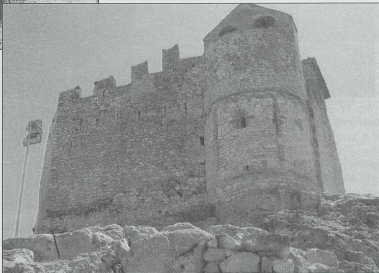
Fig. 10. De la fortificación de la antigua iglesia románica y sus ampliaciones son visibles los trazos de las almenas y un conjunto de ocho aspilleras
