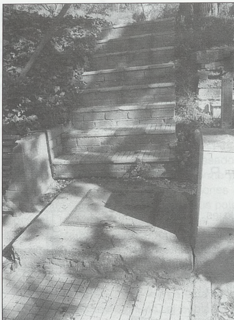
Trampilla de acceso al refugio desde las instalaciones del sanatorio
