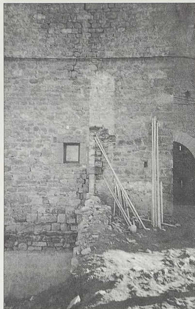
Torre sudeste durante la restauración.
