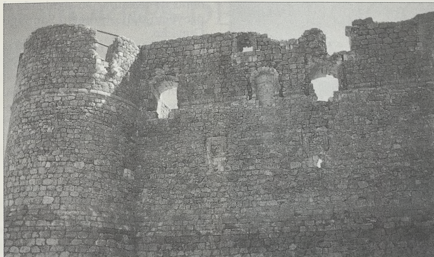
Torre noroeste y lienzo oeste. Huecos de ventanas abiertas en distintas épocas.
