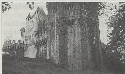
Castillo de Butrón. Detalle de la parte baja de los muros; se diferencia la parte más vieja, de coloración más clara, de la parte neogótica, más oscura.
