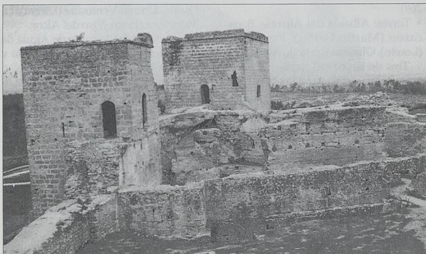
Lám. 3. Muro de diafragma que cierra el recinto septentrional de la fortificación de Alcazár de Guadaira. Foto M. Valor, 1997.
