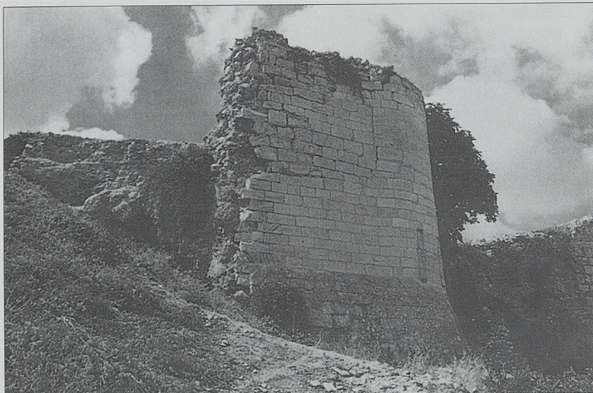
Fig. 6. Vista de la cerca exterior por el frente este.
