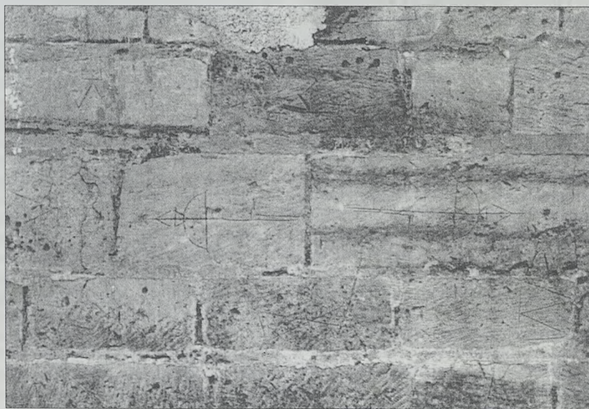
Fig. 3 Paramento del foso donde se aprecian las marcas de cantería.
