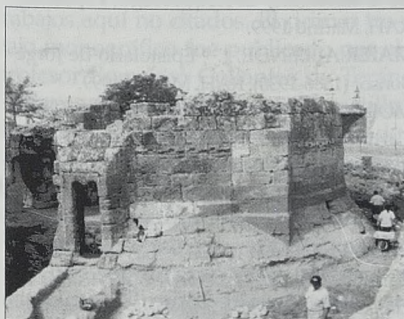
Obras de recuperación del Cubete.
