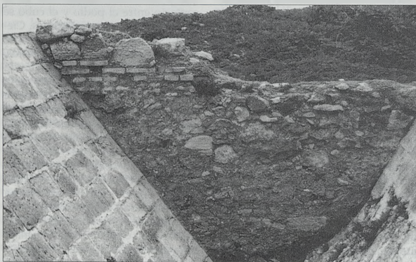
Fig. 8. Vista de la terminación del foso por su frente este.
