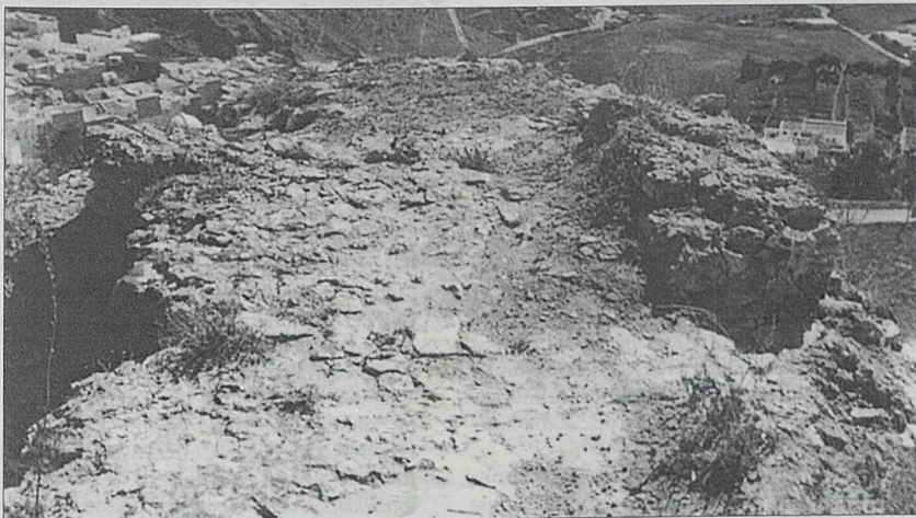
Fig. 10. Huellas del parapeto con el que se cerró la torre del homenaje
