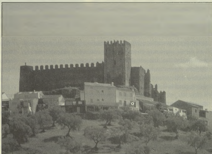
Vista del castillo de Segura de León, sobre el pueblo
