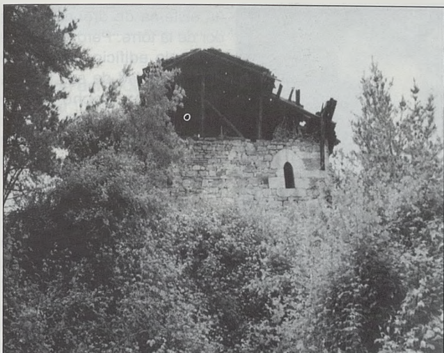
Fachada principal en mayo de 2005, casi oculta por la vegetación
