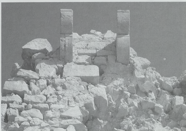
Lam. 6. Restos del matacán de la Torre d'Aguiló
