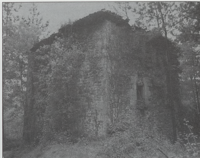
Fachadas norte y oeste. Obsérvese en ésta última la ventana germinada, hoy adintelada
