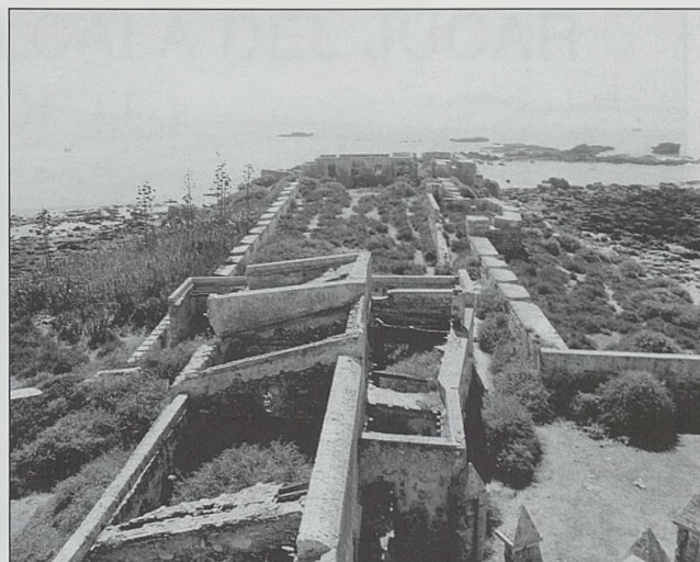
Vista de la zona centr-sur del castillo desde la torre
