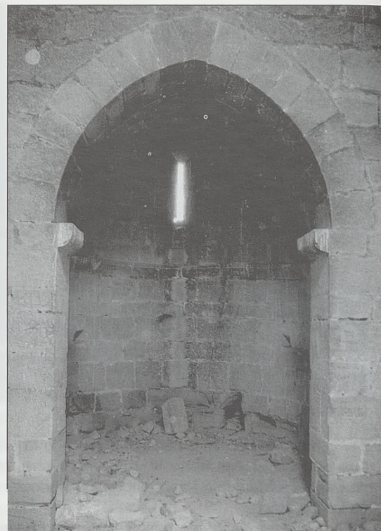
Vista, interior este, de la cota cero de la Torre del Homenaje, donde se ubicaría la Capilla
