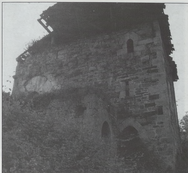
Fachada principal en junio de 1993
