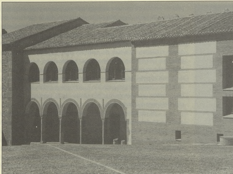
Patio de Armas tras el proceso restaurador y rehabilitador
