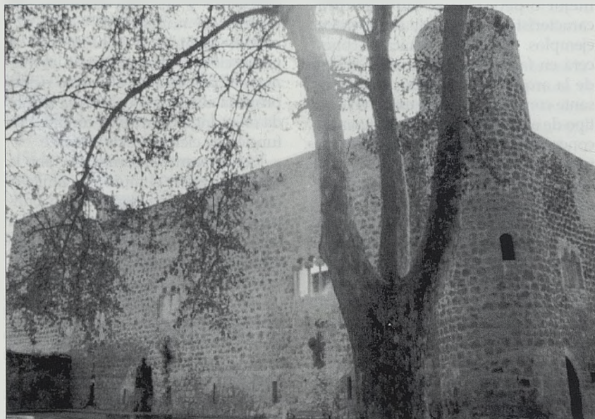
Crujía norte al exterior.
