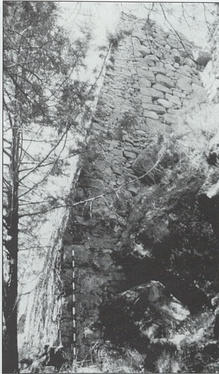
Flanco oeste. Forro Alamborado sobre torre cuadrada en inicio del tercer recinto
