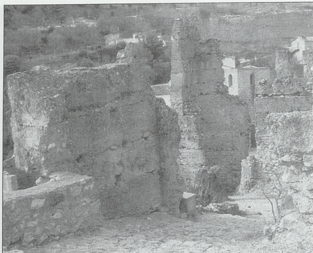
Acceso a la fortaleza
