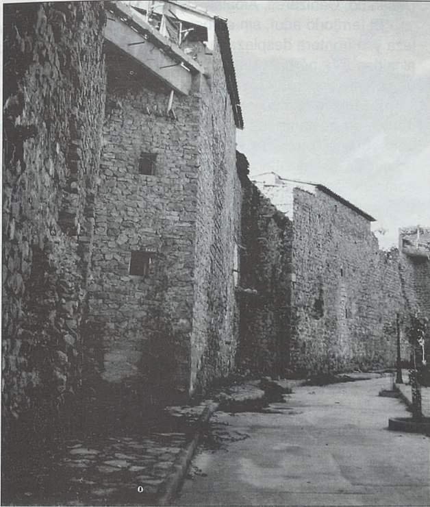
Lienco de muralla exterior a la Puerta de las Eras
