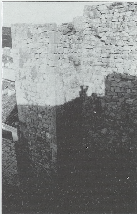
Puerta de la Eras extramuros. Tomada sobre la muralla en propiedad privada
