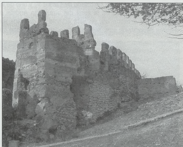
Torre IV, cara norte y aljibe
