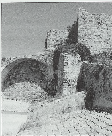
Zona intramuros en la que se ven los diferentes tejados de las casas. Las distintas edificaciones adosadas dificultan considerablemente el acceso actual a las zonas en ruina de la muralla para proceder a su restauración
