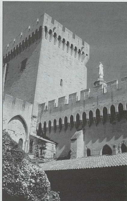
La Torre de la Campana (6) y la Capilla de benedicto XII (5), dotadas de almenas, matacanes y contrafuertes, vistas desde el Claustro (9)
