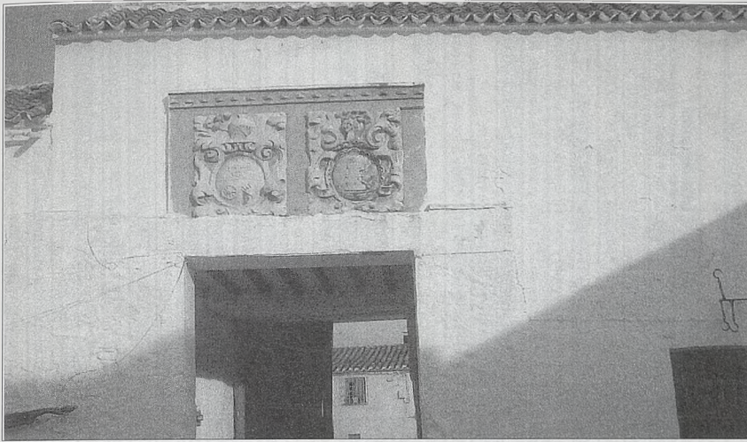
Escudos nobiliarios en el interior del patio «Cortijo de la Marquesa»
