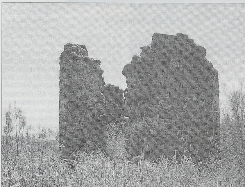
Foto nº 1 Torre del Cortijo Grande. Almogía
