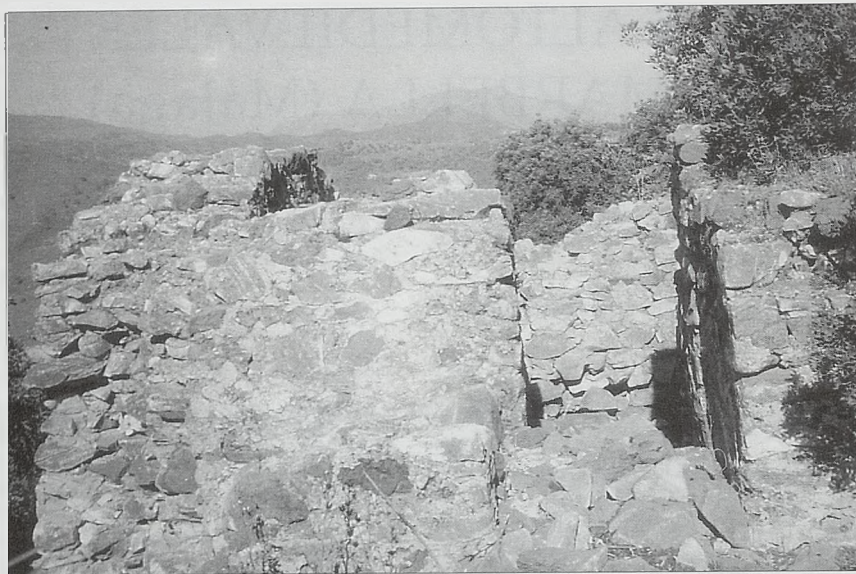
Foto nº 1 Torre nº1 del Nicio. Al fondo enlace óptico con Montemayor
