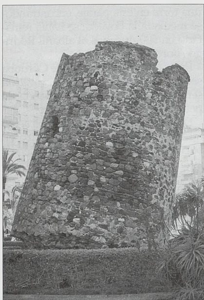
Torre Ladeá o Ladeada (Algarrobo)
