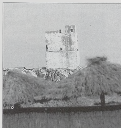
Torre del «Salto de la Mora»
