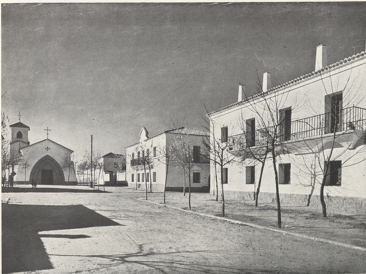
Viviendas. Al fondo, la Iglesia.
