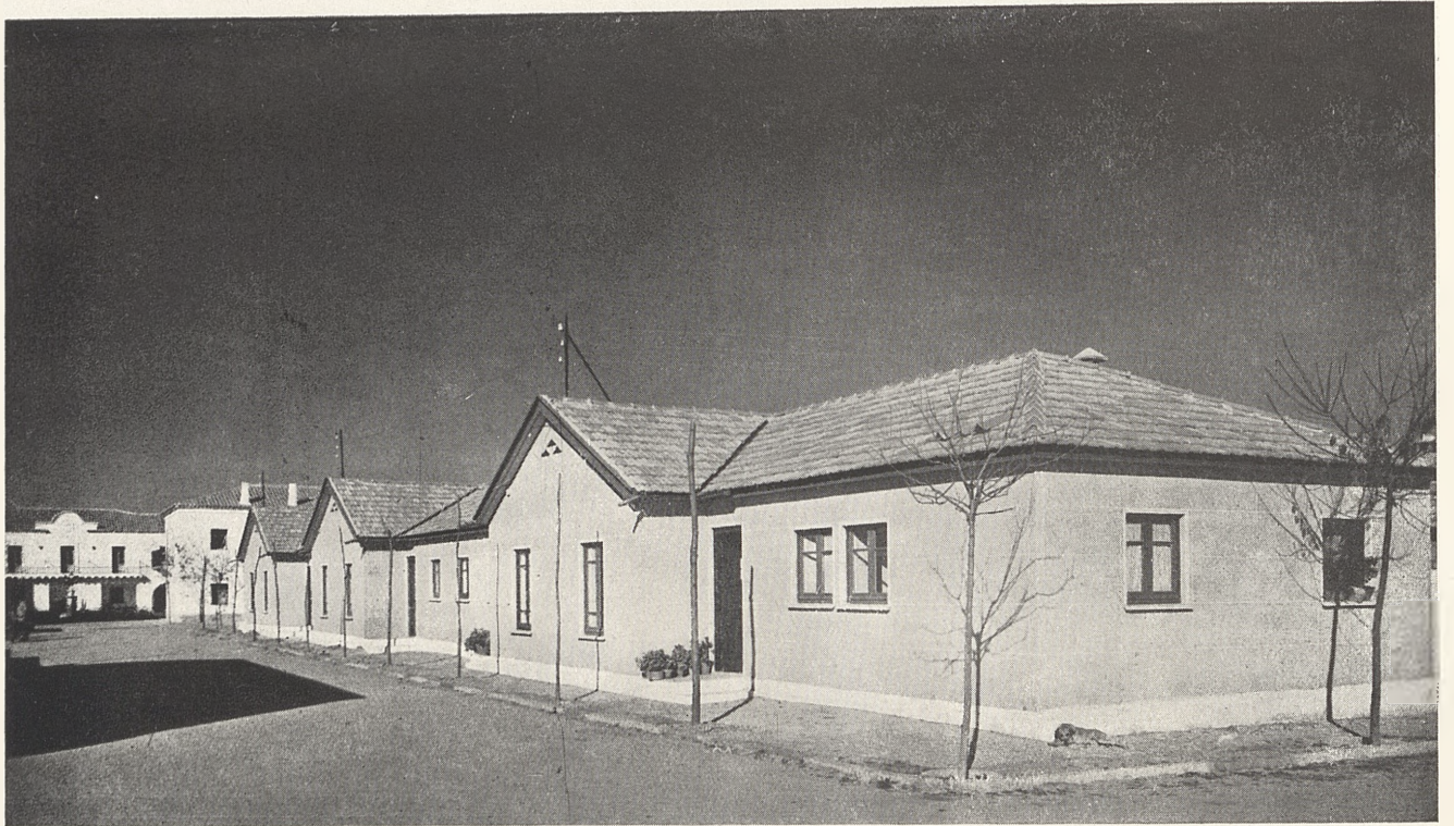
Grupo de viviendas prefabricadas.
