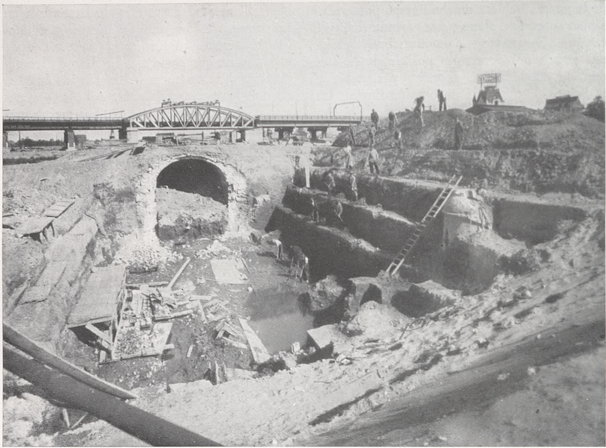
Los cimientos, muy profundos, de las antiguas construcciones destruidas, fueron extraídos, con objeto de cimentar por nuevos procedimientos.
