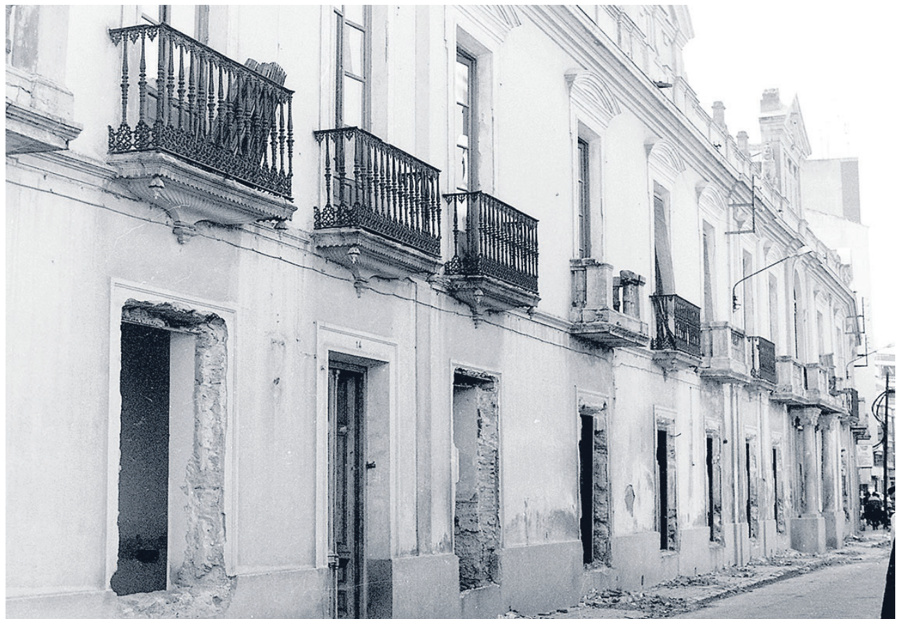
Imagen de la demolición de la Audiencia
