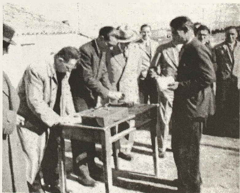
Reparto de gratificaciones con motivo del calado del túnel. 1948
