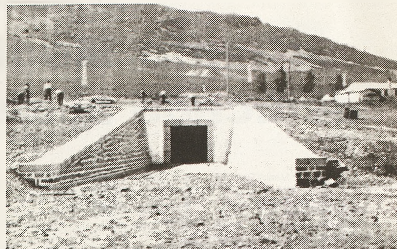
Embocadura Norte del Túnel de Mestanza. 1948
