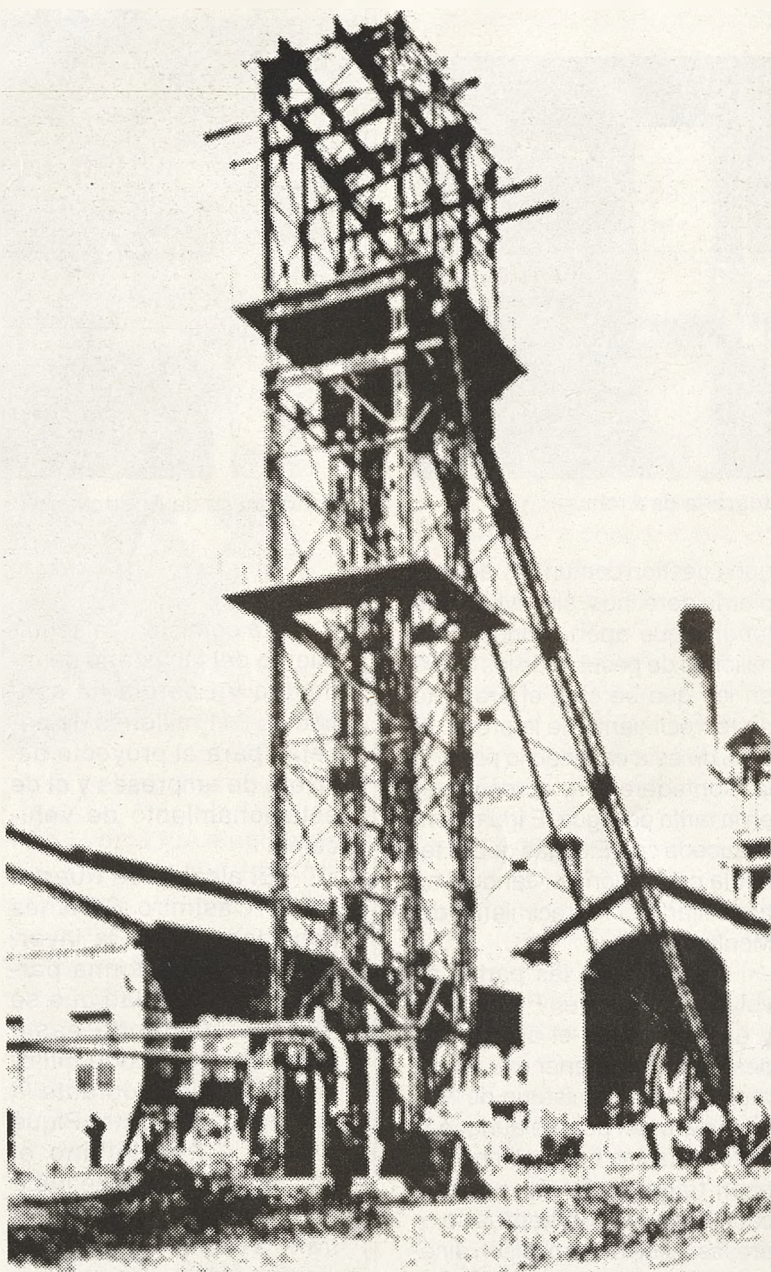
Mina «Asdrubal» - Castillete del pozo Santa María en construcción. Año 1910
