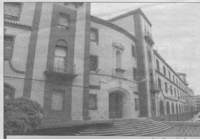
Foto: Diputación Provincial Exterior de la Residencia universitaria Santo Tomás de Villanueva.
