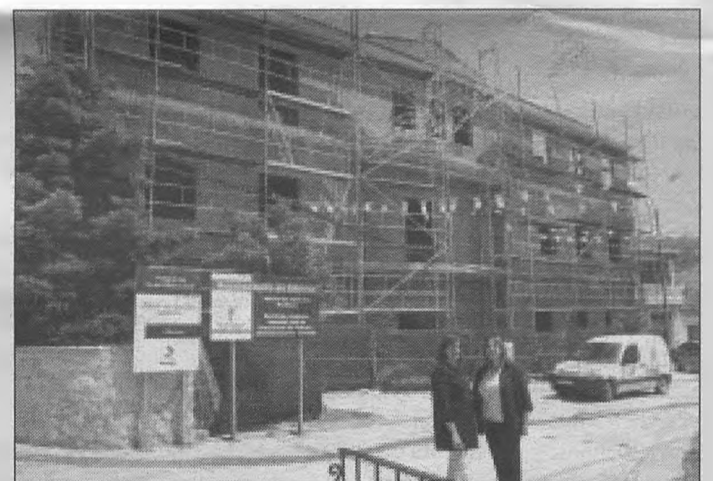
Foto: Nuria Gil Riansares Serrano, acompañada de la alcaldesa Josefa Sánchez, visitó las obras del futuro edificio de usos múltiples de la localidad guadalajareña.
