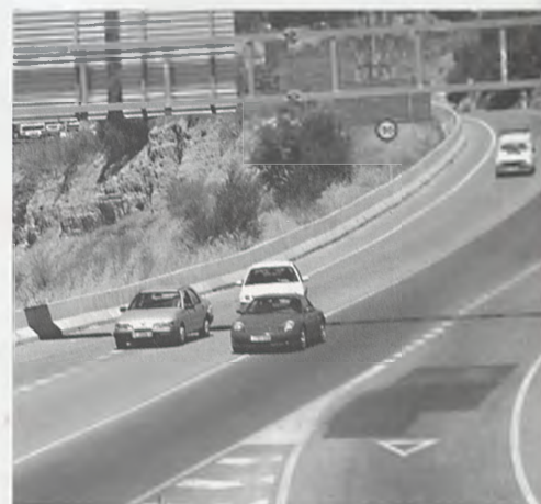
La autovía de Castilla-La Mancha, un gran proyecto para la región
