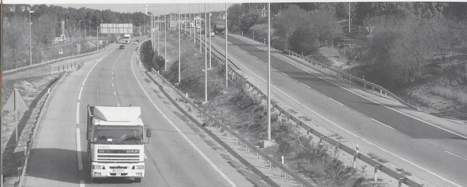
La autovía Madrid-Toledo, N-401, en la imagen, soporta cerca de 100.000 vehículos diarios.
