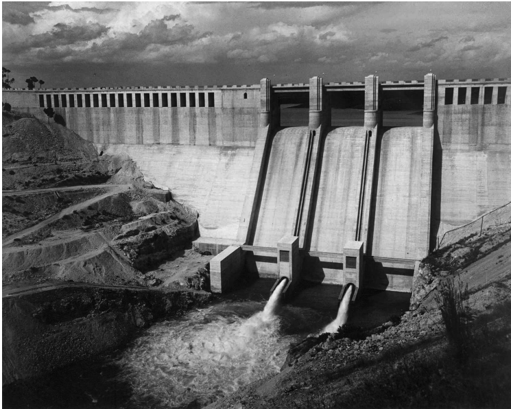
Vista de los aliviaderos y desagües de fondo.
