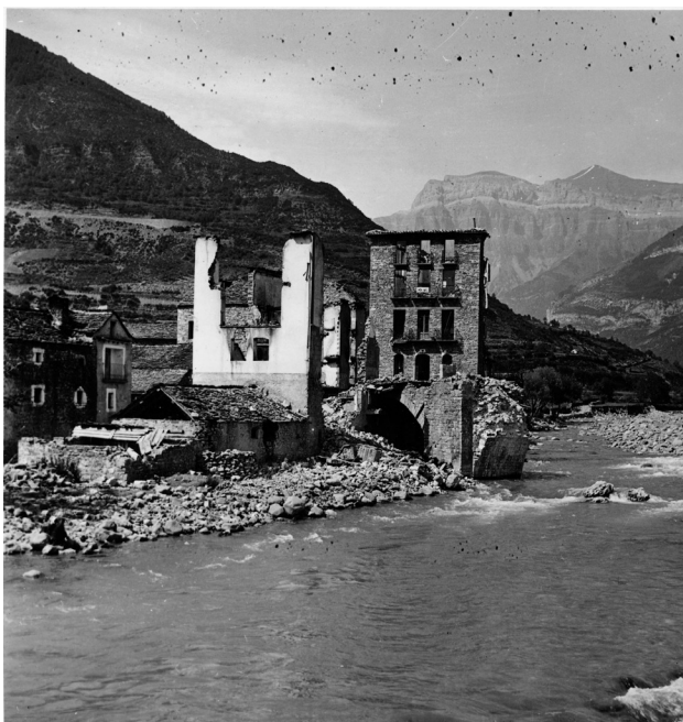
Santa María del Villar, Broto destruido . El río Ara y, al fondo, el Mondaruego. Colección del autor.
