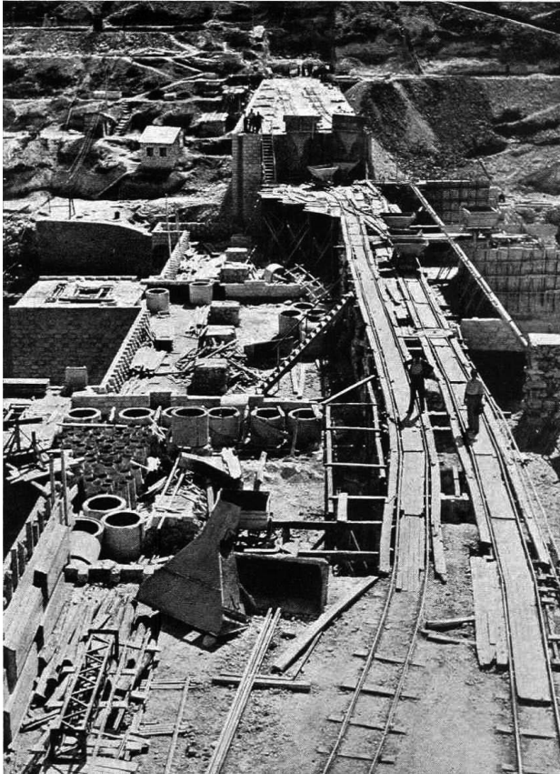
Construcción de la presa. Hormigonado de la coronación (1948).
