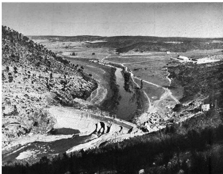
Construcción de la ataguía (1943).
