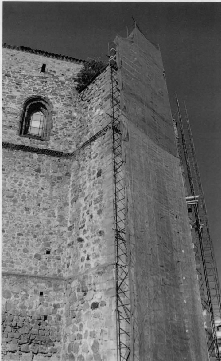
Iglesia de la Asunción. Inicio de las obras de restauración.
