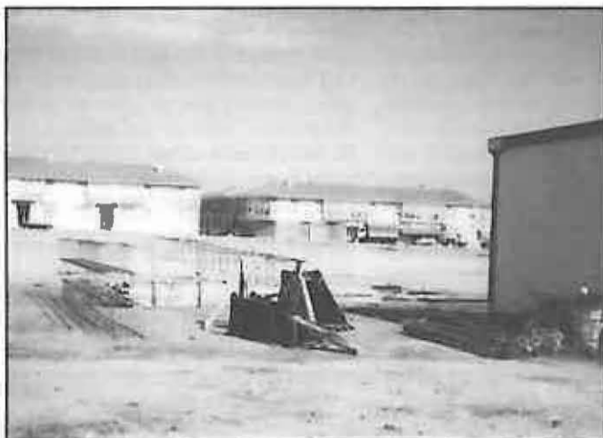
Por fin empezaron las obras del nuevo colegio de primaria de nuestro pueblo. Si todo va según lo previsto, el próximo curso podrá ser inaugurado.
