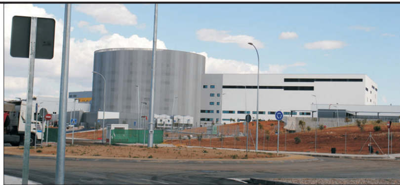
Rotonda que se construyen para dar acceso al hospital, junto al SESCOAM.
