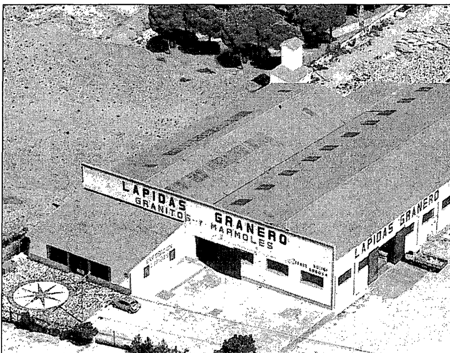
Las instalaciones de Lápidas y Sarcófagos Granero tienen una superficie de 3.000 m2 construidos.
