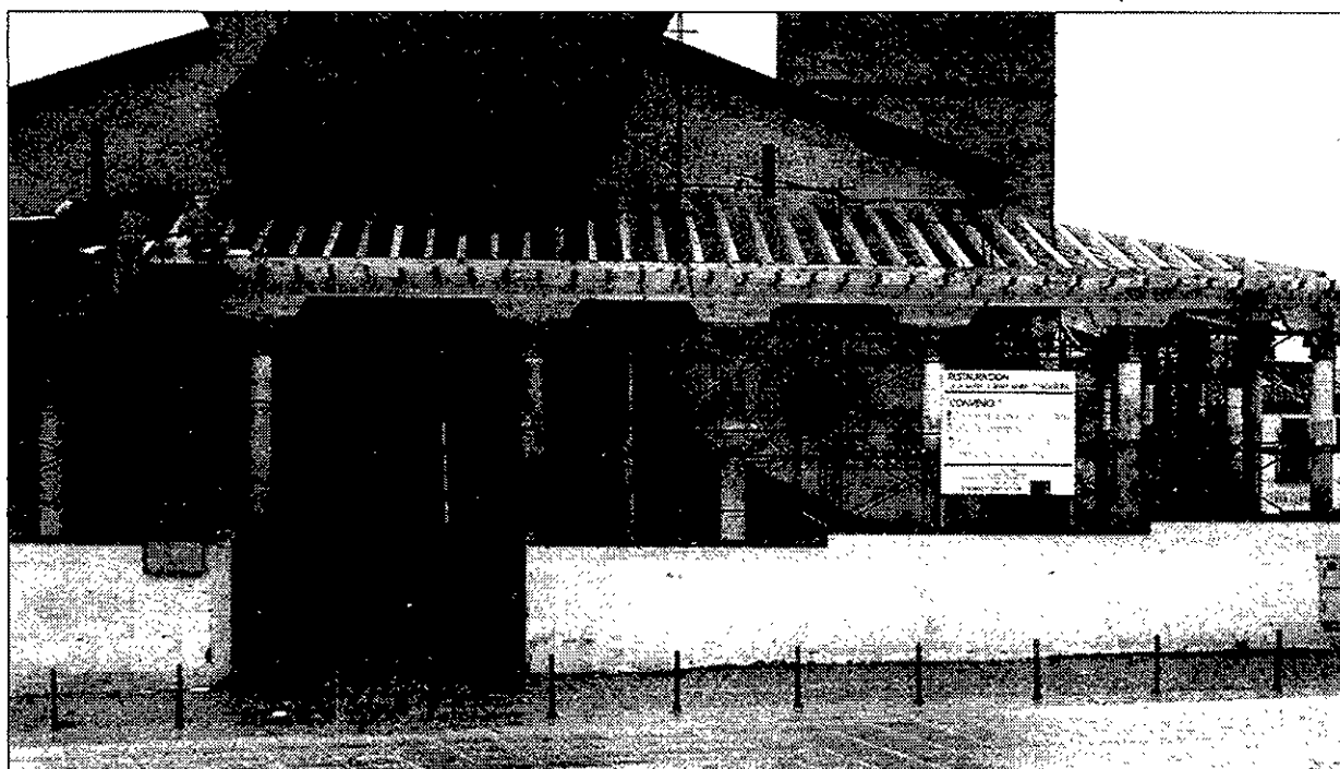
Una vez colocada la cubierta del atrio, se instalarán los peldaños y concluirá la primera fase de la rehabilitación.
