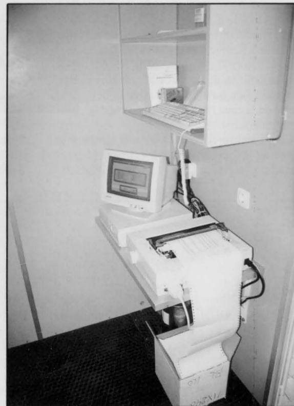
Las cabinas para medir la contaminación atmosférica - como la que aparece en la fotografía - alojan en su interior un sofisticado equipo para controlar los niveles de partículas en suspensión en el aire. Toda la información la transmiten al Centro de Control de Datos.
