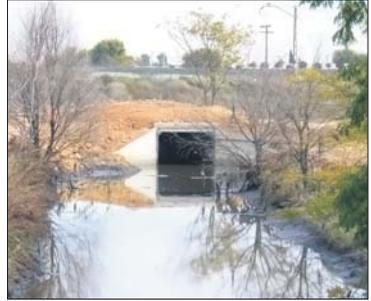
do otro con mayor altura para no impedir el curso de las aguas en caso de elevación del caudal, y evitar así que el puente actúe como dique y provoque desbordamientos.
