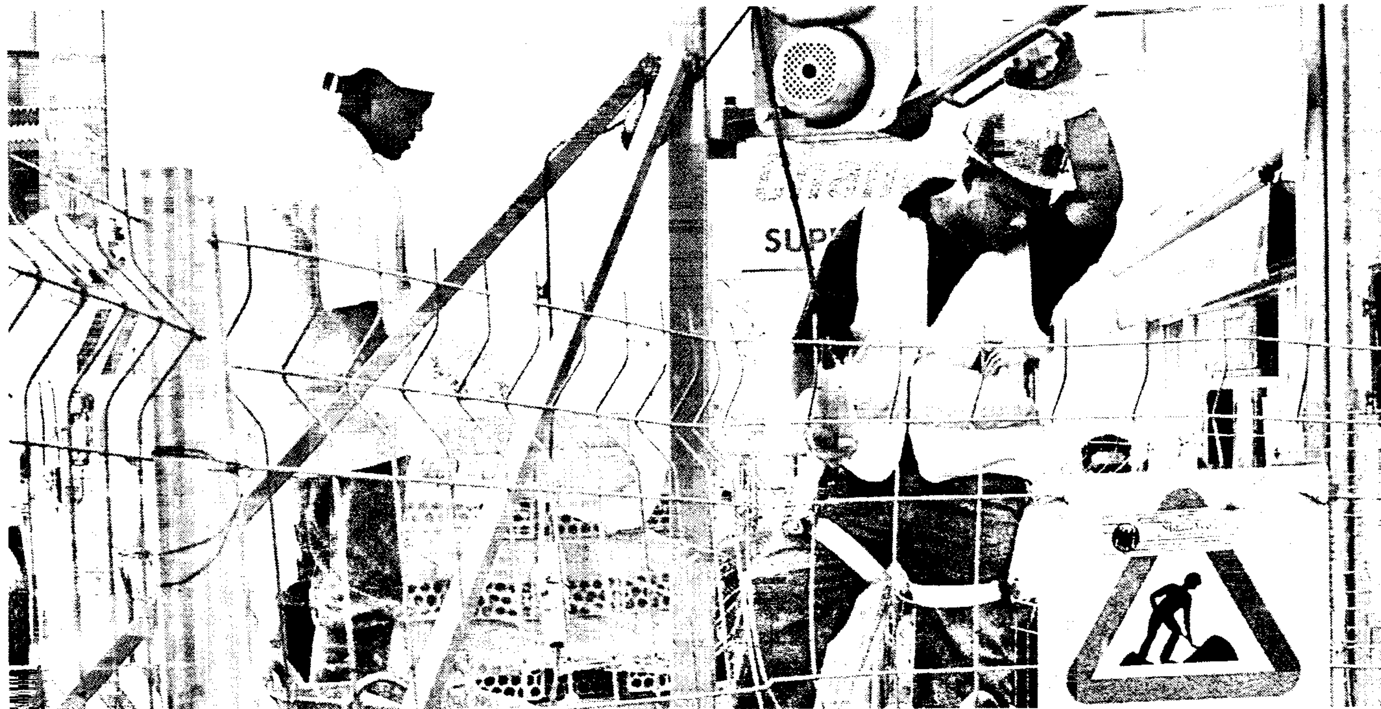
Desde el Gobierno se asegura que los inspectores de trabajo han visitado más de 6.700 obras para comprobar su seguridad
