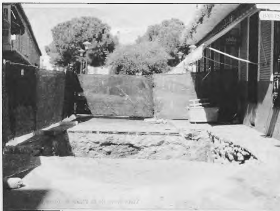
Se han empezado las obras para ocultar bajo tierra, algunos contenedores que por su ubicación resultan antiestéticos y malolientes.
